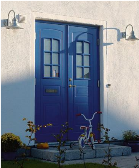
Figur 3. Inspirationsbild av färgval på entrédörr. (byggab.com)
