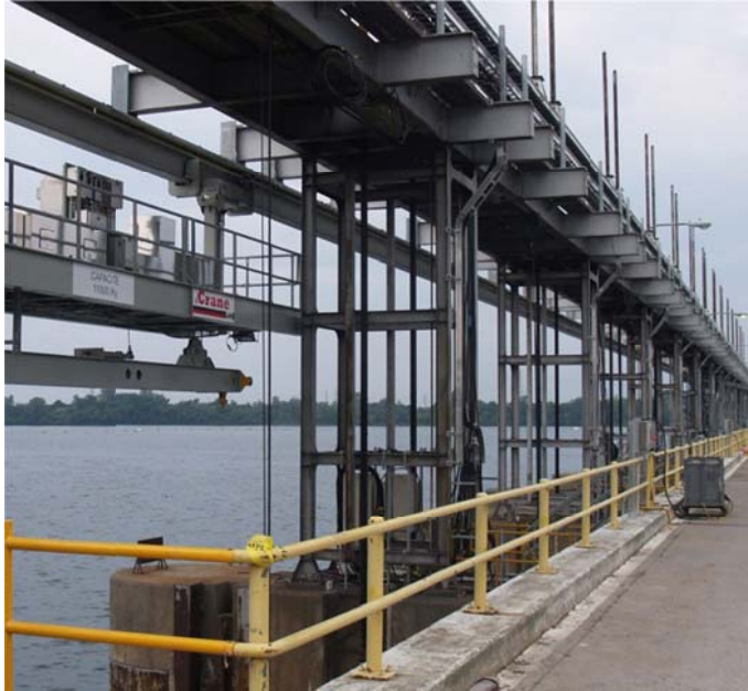
Kuva 15. Yksikiskoista rataa pitkin liikkuva settipalkkien nostolaite. (iCrane)
