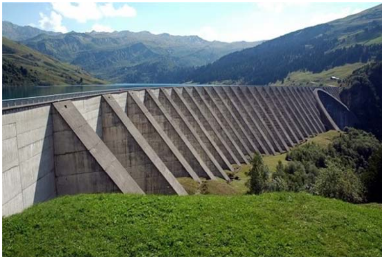
Kuva 11. Roselendin pato Ranskassa. Pato on tyypiltään ripapato (lamellipato) ja se toimii vesivoimakäytössä. (Adrien Mortini)
