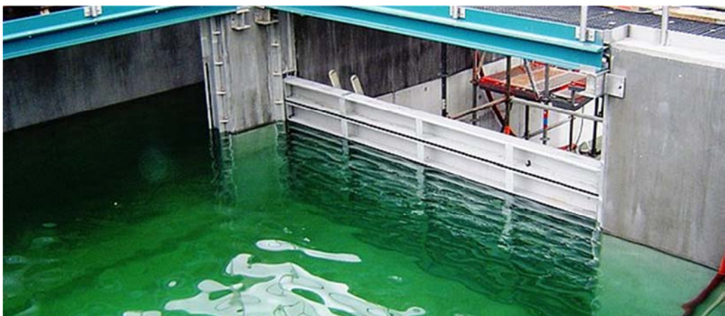
Kuva 16. Settipalkkien käyttöä vedensääntelyrakenteessa. (IBS)
