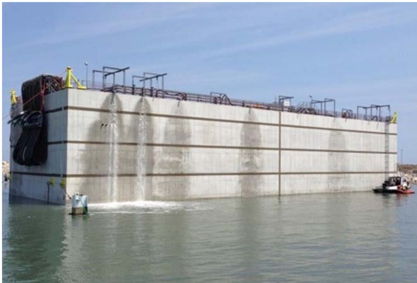
Kuva 20. Kasuunin uittamista Venetsiassa, Italiassa. Kasuuni on osa Venetsiaan tulevaa MOSE-tulvaestettä. (Strukton)
