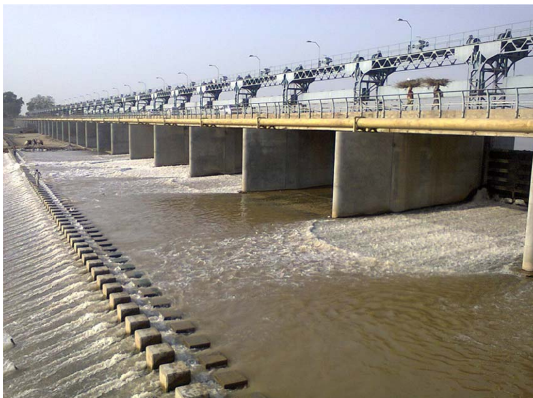
Kuva 12. Ballokin säännöstelypato Pakistanissa. Padon avulla säännöstellään viljelymaiden vedensaantia. Padossa on avattavat patoluukut ja sen toimintaperiaate on samanlainen kuin settipadoissa. (F9view)
