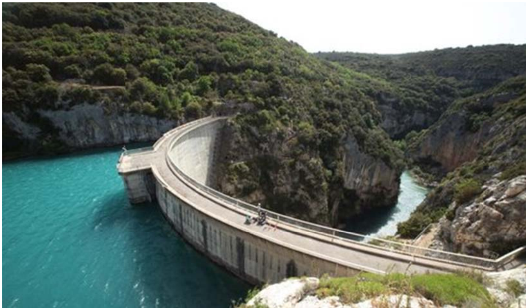
Kuva 7. Sainte-Croixin pato Ranskassa. Padon staattinen toiminta perustuu vaakasuuntaiseen holviin. (Var-matin)
