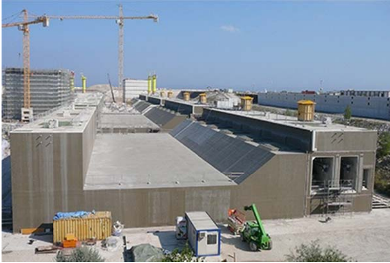
Kuva 18. Venetsian tulvaesteeseen tulevien kasuunien rakentamista telakalla. (Enerpac)
