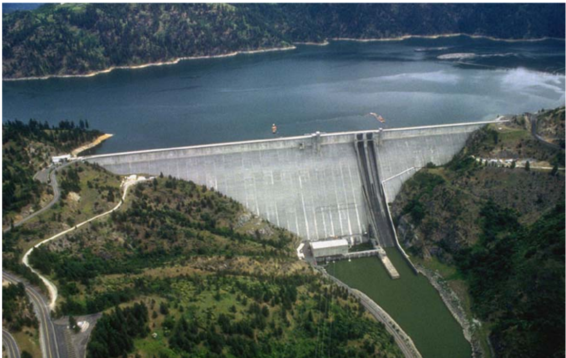
Kuva 8. Dworshakin pato Yhdysvalloissa. Pato toimii gravitaatorakenteena. (Tata & Howard)
