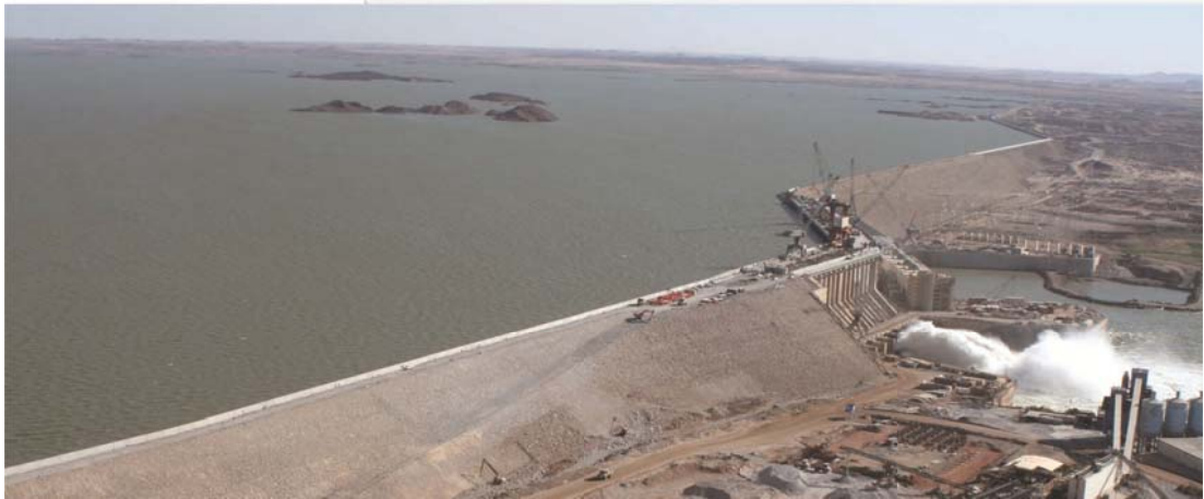
Kuva 6. Merowen pato Sudanissa. Pato toimii gravitaattiorakenteena. (CWE)
