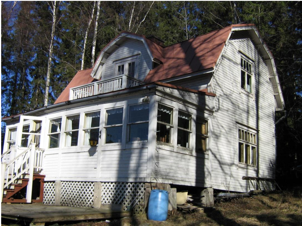
Kuva 4. Huvilan etelä- ja länsipuoli.
