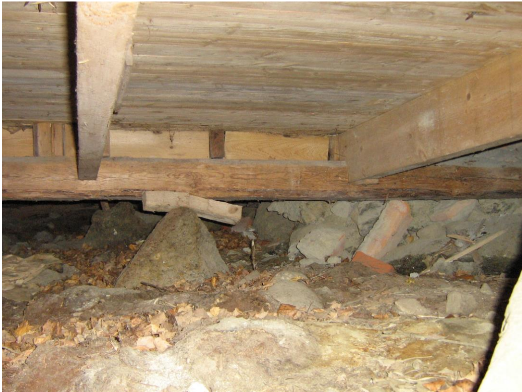
Kuva 12. Huvila on rakennettu kivien päälle.
