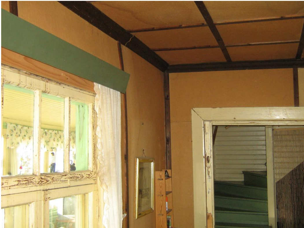
Kuva 9. Huvilan ja kuistin välinen seinä.
