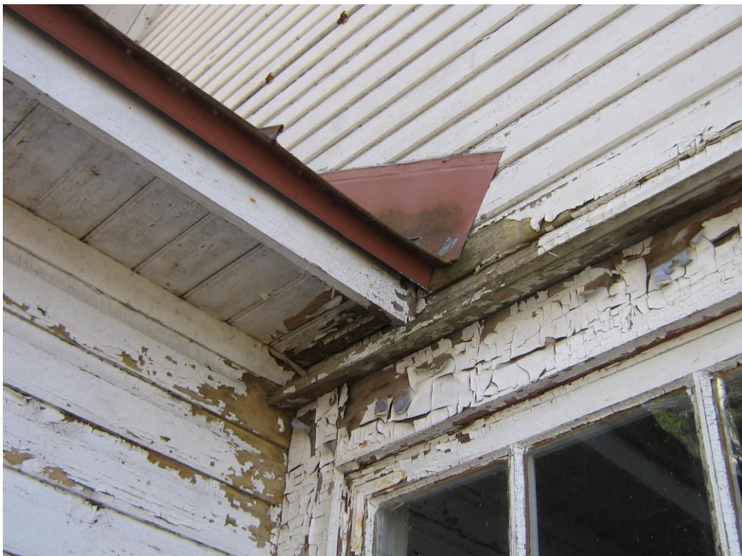
Kuva 11. Pohjoisseinän lisäsiivekkeestä puuttuu räystäskouru.
