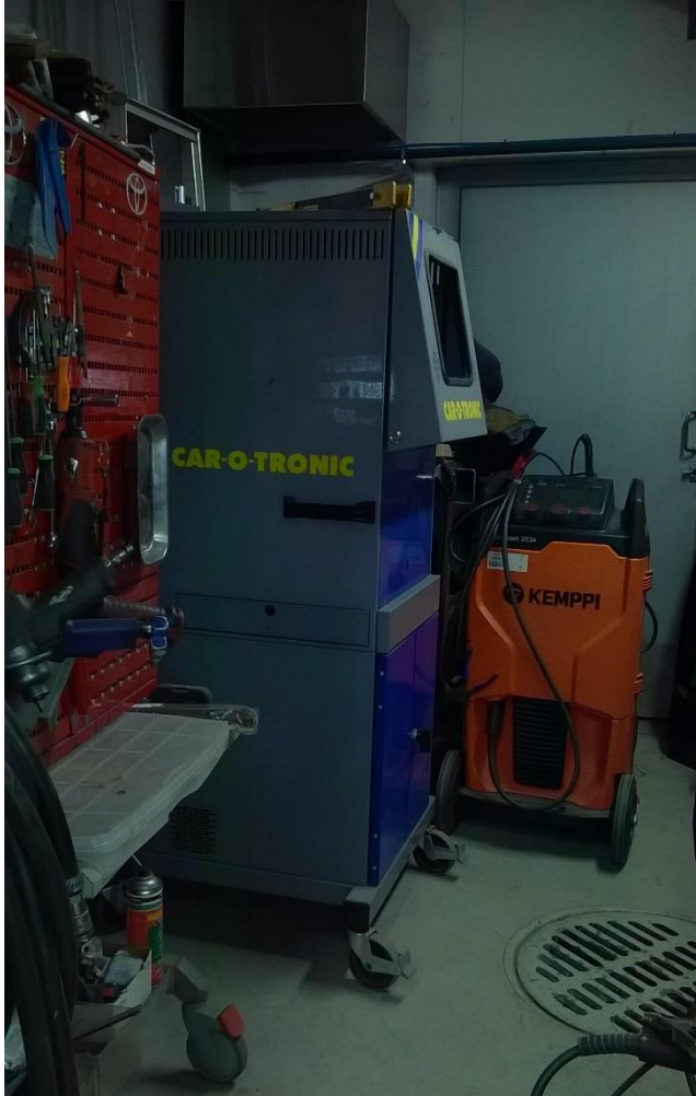
Kuva 1. Joidenkin laitteiden käytettävyys oli hankalaa.
