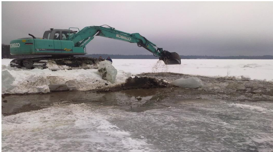
Kuva 15. Ruoppausta jään päältä Oksjärvellä (Kuva Tuomo Mäkelä)
