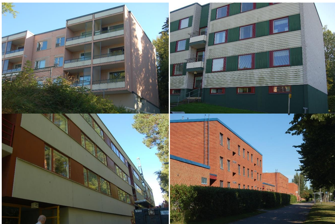
Figur 4. Vanliga fasadtyper på byggnader byggda 1960–1975. Rutelement, blandning mellan plåt och tegel, blandning mellan bandelement och fasadskivor, tegel.
