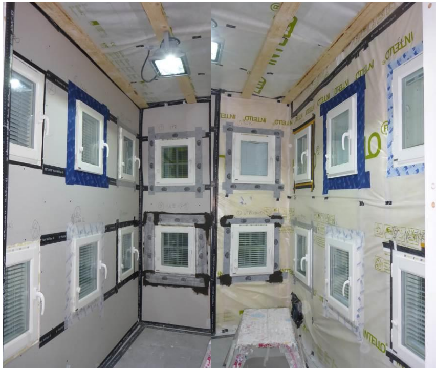
Kuva 6. Yleiskuva testirakennuksen sisäpuolelta ja liitosnauha-asennuksia.
