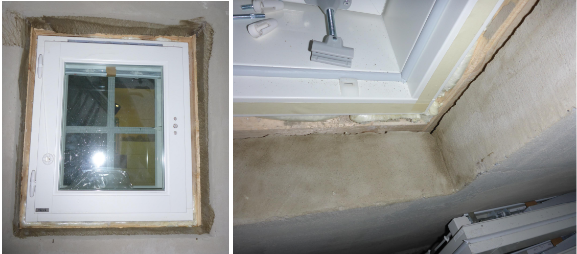
Kuva 44. Ikkunakarmin ja ulkoseinärakenteen välinen liittymä ennen liitosnauha-asennuksia.
