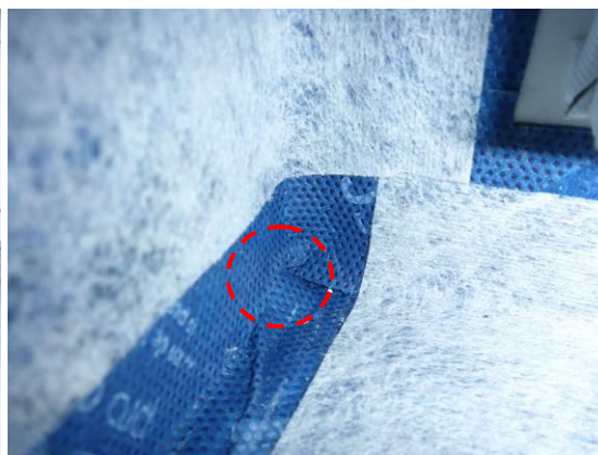
Kuvat 9 ja 10. Merkkiainelaitteella havaittiin ilmavuotoja kaikista nurkissa nurkkakappaleen taka-kulmista. Vuodot olivat voimakkuudeltaan vähäisiä.
