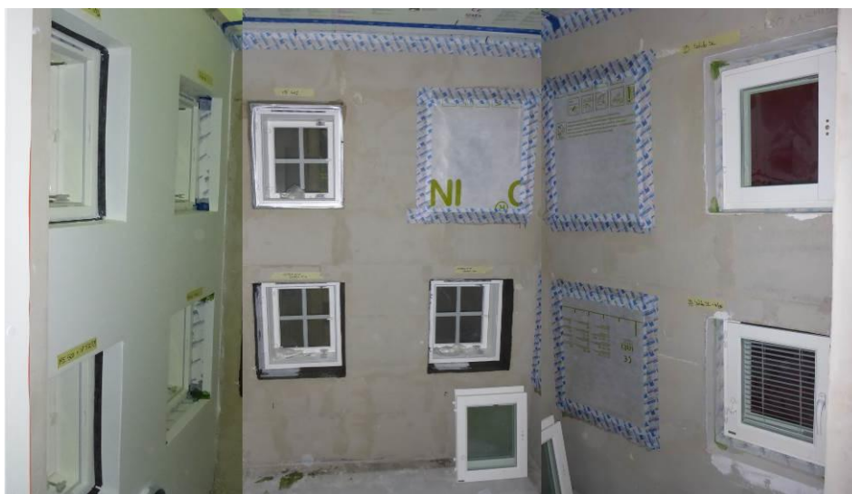
Kuva 6. Yleiskuva testirakennuksen sisäpuolelta ja liitosnauha-asennuksia.
