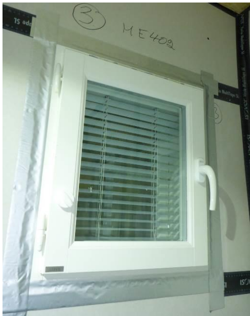
Kuva 1. Ikkunaliittymän tiivistys kipsilevyn pintaan toteutettuna Illbruck ME 402 –liitosnauhalla.
