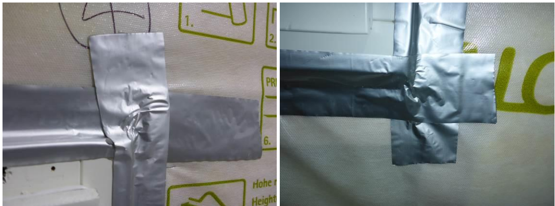
Kuvat 2 ja 3. Ikkunan nurkkaliitokset toteutettiin asentamalla eri sivujen nauhat päällekkäin, ristiin.
