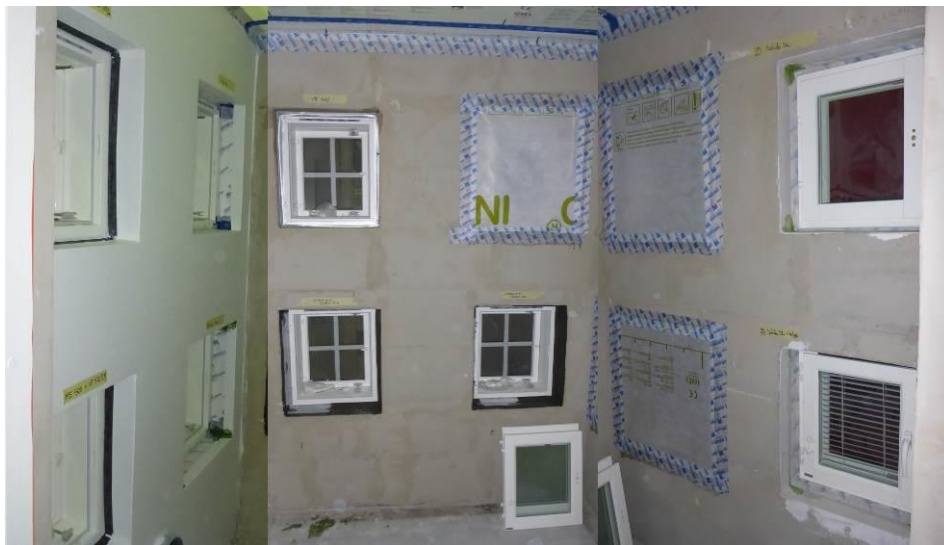
Kuva 6. Yleiskuva testirakennuksen sisäpuolelta ja liitosnauha-asennuksia.
