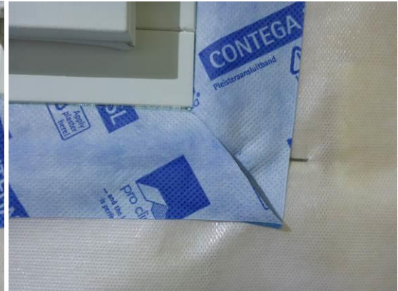
Kuvat 6 ja 7. Ikkunan alanurkkien nurkkaliitokset toteutettiin taittamalla nauhaa siten, että taitos mahdollisti liitosnauhan kääntymisen laskostettuna nurkan ympäri.
