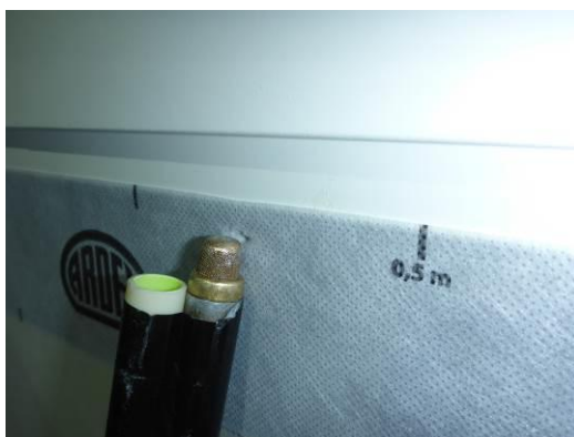
Kuva 6. Kaasun leviämistä rakenteessa varmistettiin tekemällä reikä nauhan pintaan. Tehdyistä reiästä havaittiin kaasun levinneen hyvin mallirakennuksen ulkoseinärakenteessa.
