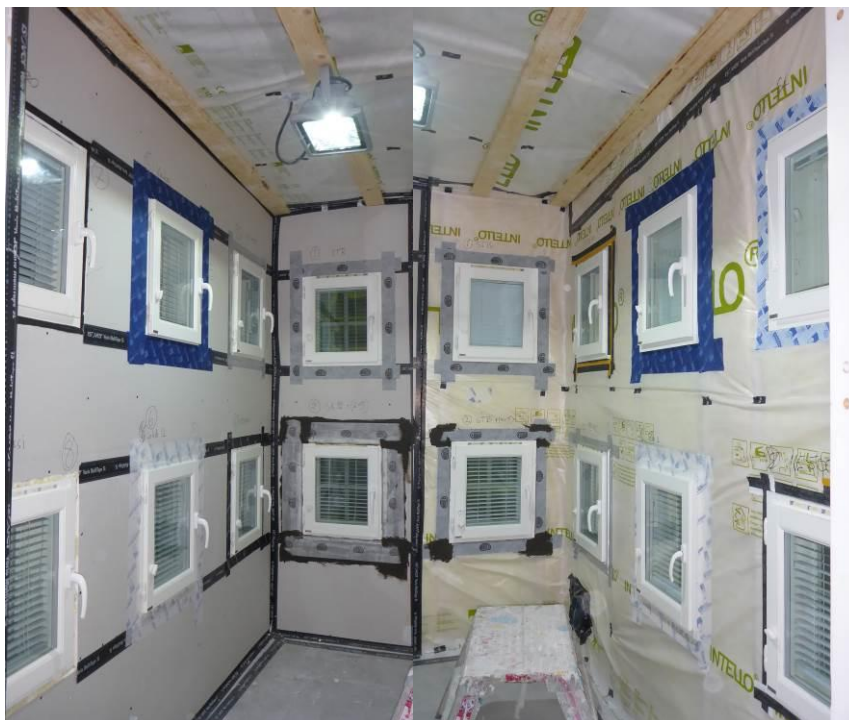
Kuva 11. Yleiskuva testirakennuksen sisäpuolelta ja liitosnauha-asennuksia.
