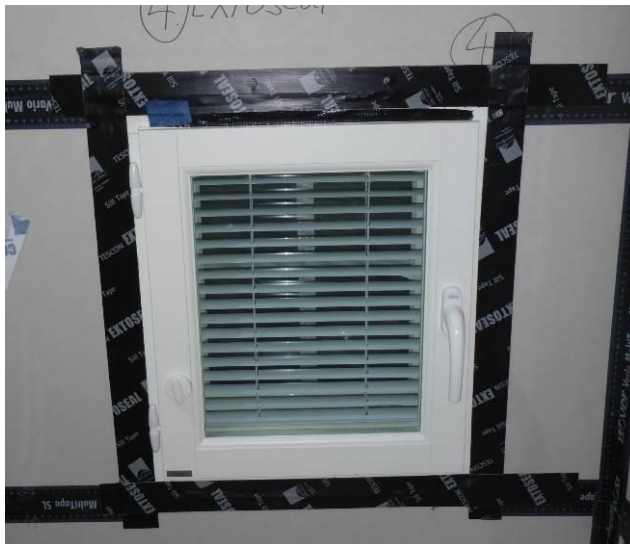
Kuva 1. Ikkunaliittymän tiivistys kipsilevyn pintaan toteutettuna Extoseal Encors butyyliinauhalla.
