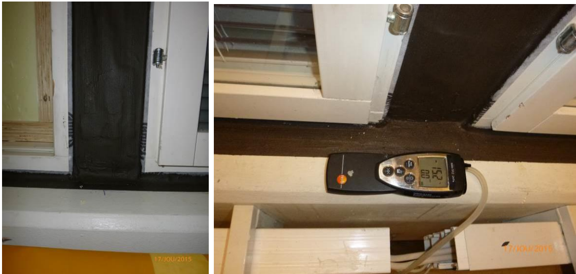
Kuva 17. Ikkunaliittymien tiivistys tarkoitukseen soveltuvalla vedeneristystuotteella vahvikenauhaa käyttäen. (Kuva: Petri Sallinen, Vahnen Rakennusfysiikka Oy.)
