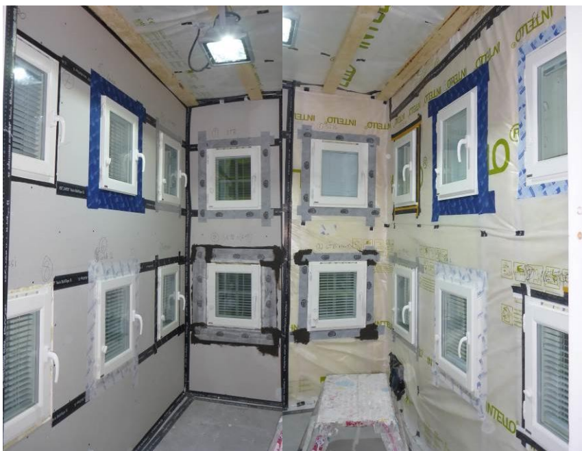
Kuva 39. Yleiskuva testirakennuksen sisältä. Kuvassa on ikkunaliittymille tehdyt asennukset ja seinäpintojen puolittainen sisäverhouslevytyt vasemmalla.
