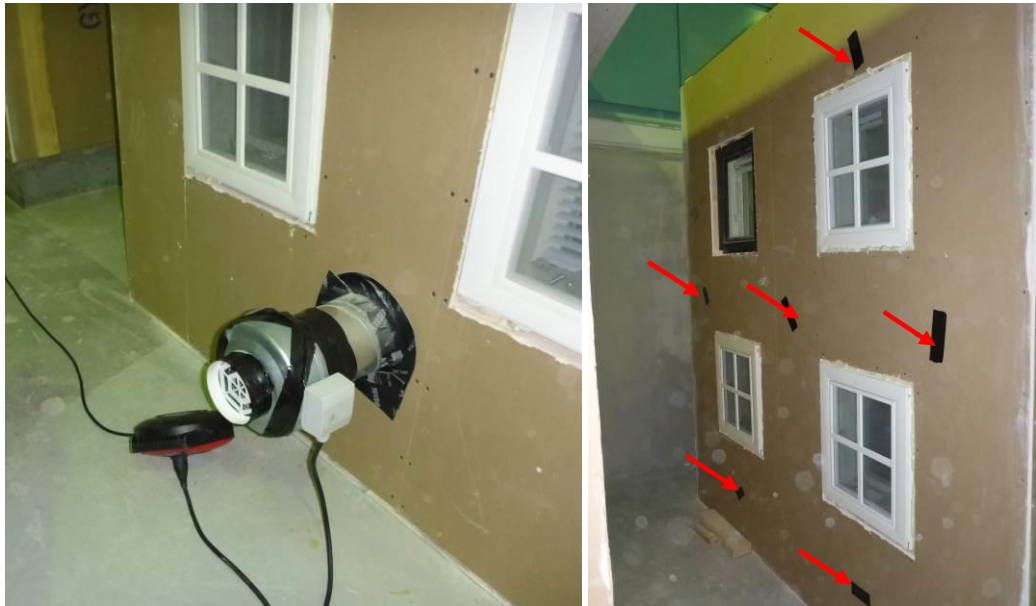
Kuvat 5 ja 6. Testijärjestely vasemmalla alipaineistukseen käytetty kanavapuhallin, oikealla merkkikaasun syöttöpisteitä ulkoseinärakenteessa.
