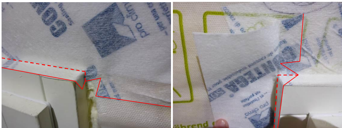
Kuvat 2 ja 3. Ikkunan nurkkaliitokset toteutettiin asentamalla eri sivujen nauhat ristiin, taittaen nauhan liepeet päällekkäin leikkauskohdasta. Asennetun liitosnauhan reuna on merkitty kuvaan punaisella viivalla ja liitosnauhan taitos punaisella katkovivalla.
