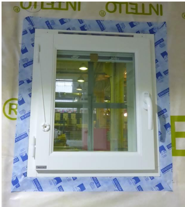
Kuva 1. Ikkunaliittymän tiivistys höyrynsulkukalvon pintaan toteutettuna Contega SL –liitosnauhalla.
