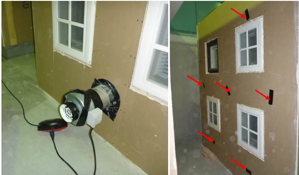
Kuvat 4 ja 5. Testijärjestely vasemmalla alipaineistukseen käytetty kanavapuhallin, oikealla merkkikaasun syöttöpisteitä ulkoseinärakenteessa.
