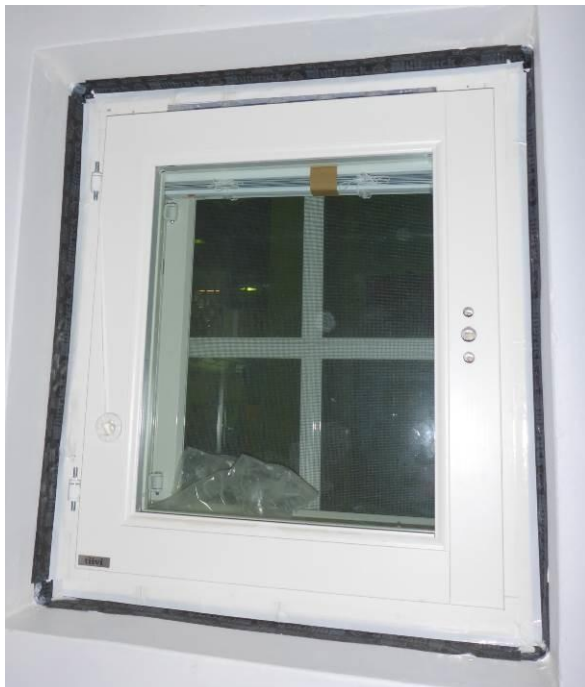
Kuva 1. Ikkunaliittymän tiivistys harkkorakenteisen seinän ikkuna-aukon pielten pintaan toteutettuna Illbruck ME500 –liitosnauhalla ja SP 525 -tiivistysmassalla.
