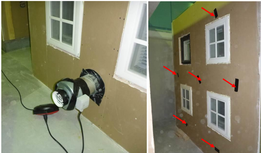
Kuvat 6 ja 7. Testijärjestely vasemmalla alipaineistukseen käytetty kavanapuhallin, oikealla merkkikaasun syöttöpisteitä ulkoseinä-rakenteessa.
