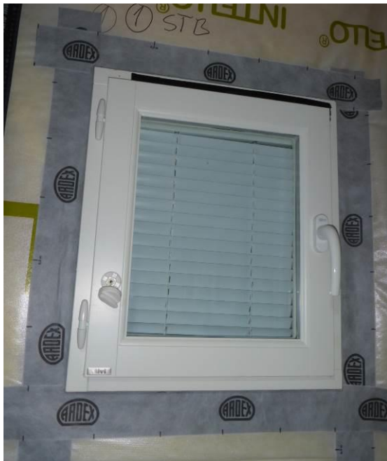
Kuva 1. Ikkunaliittymän tiivistys höyrynsulkukalvon pintaan toteutettuna Ardex STB 75-15 -karminauhalla.
