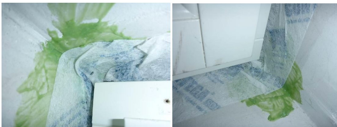
Kuvat 10 ja 11. Aistinvaraisessa tarkastelussa liitosnauhan pinnoilla havaittiin jonkin verran poimuuntumista etenkin nurkkien läheisyydessä, joissa nauha oli käännetty karmilta nurkan yli. Poimut oli kuitenkin tasoitettu niin, että aistinvaraisesti ei mahdollisia ilmayhteyksiä liitoksen läpi voitu havaita
