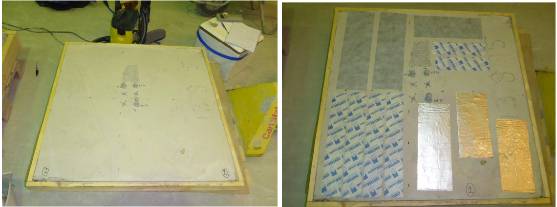
Kuva 48. Betonialusta nro. 2 ennen liitosnauha-asennuksia ja asennusten jälkeen, hiomaton betonipinta ilman pohjustekäsittelyä.
