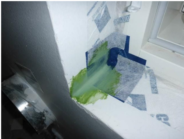
Kuva 5. Nurkkakappaleiden ja ikkunapielien nurkkien rajapinnat tiivistettiin siveltävällä Wyf-lexa –tiivistysmassalla
