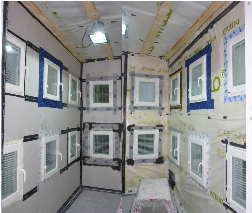
Kuva 5. Yleiskuva testirakennuksen sisäpuolelta ja liitosnauha-asennuksia.
