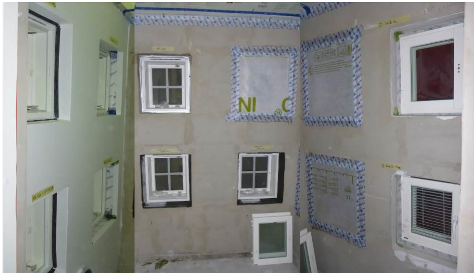
Kuva 9. Yleiskuva testirakennuksen sisäpuolelta ja liitosnauha-asennuksia.
