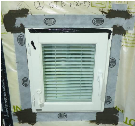
Kuva 1. Ikkunaliittymän tiivistys höyrynsulkukalvon pintaan toteutettuna Ardex STB 75-15 –karminauhalla ja 8+9 -vedeneristeellä.
