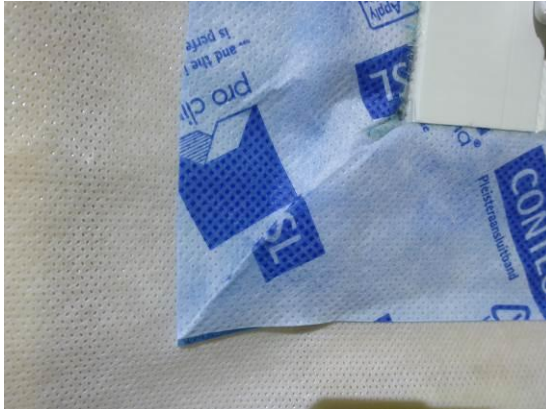
Kuvat 6 ja 7. Ikkunan alanurkkien nurkkaliitokset toteutettiin taittamalla nauhaa siten, että taitos mahdollisti liitosnauhan kääntymisen laskostettuna nurkan ympäri.
