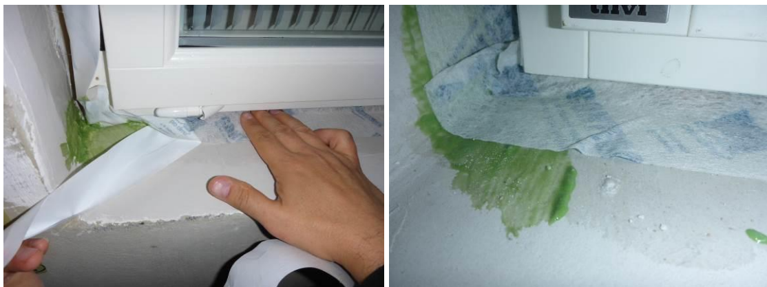
Kuvat 6 ja 7. Asennuksen yhteydessä, etenkin liitosnauhan nurkkataitoksissa havaittiin nauhan pinnan poimuuntuvan. Syntyneet poimut tasoittuivat painettaessa liitosnauhaa ikkunapielen pintaan
