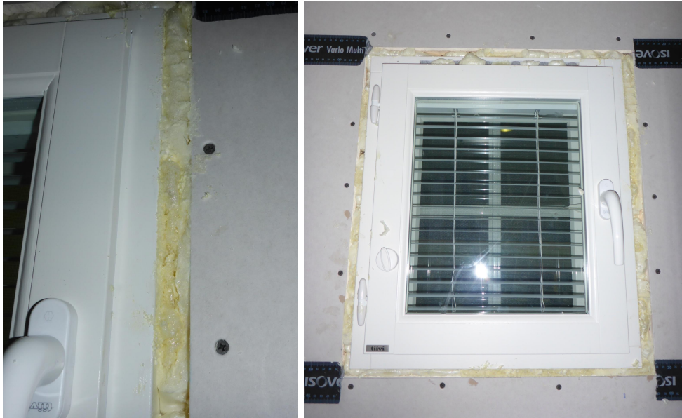
Kuva 40. Ikkunakarmin ja ulkoseinärakenteen välinen liittymä ennen puhdistusta ja liitosnauha-asennuksia.
