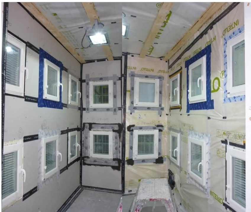
Kuva 6. Testirakennuksen sisäpuoli ja liitosnauha-asennukset.
