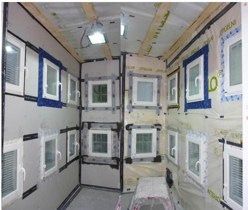
Kuva 5. Yleiskuva testirakennuksen sisäpuolelta ja liitosnauha-asennuksia.
