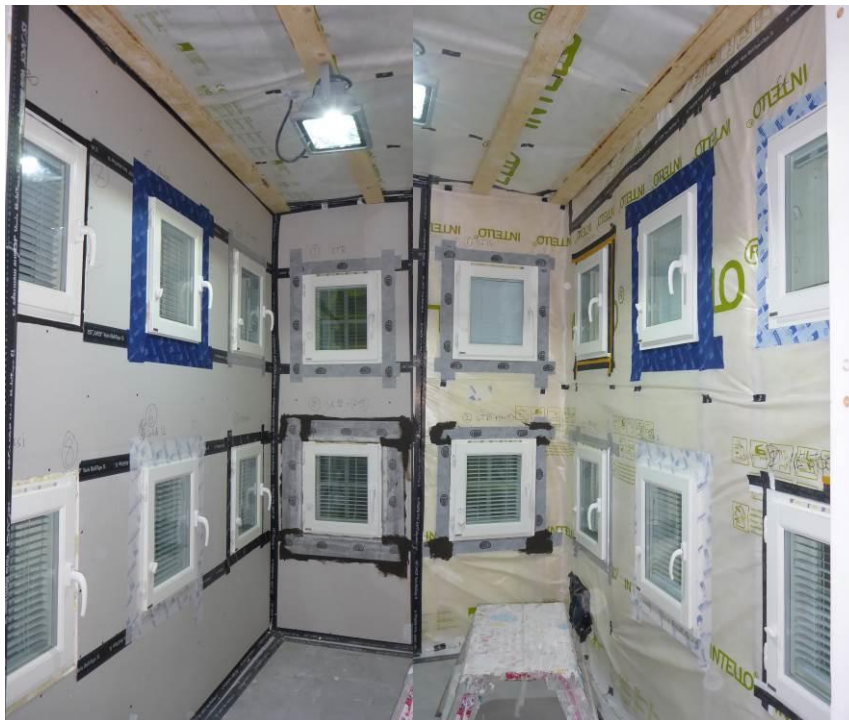
Kuva 5. Yleiskuva testirakennuksen sisäpuolelta ja liitosnauha-asennuksia.
