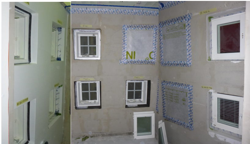
Kuva 43. Yleiskuva testirakennuksen sisältä. Kuvassa on ikkunaliittymille tehdyt asennukset.
