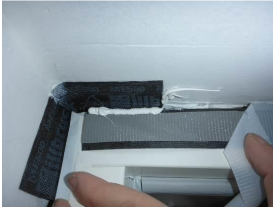
Kuva 6. Liitosnauhojen liimapintojen väliset raot ja liitosnauhojen limityksen saumat tiivistettiin SP 525 –tiivistysmassalla ennen liitosnauhojen kiinnittämistä ikkunapielen pintoihin ja nurkkakappaleiden päälle.
