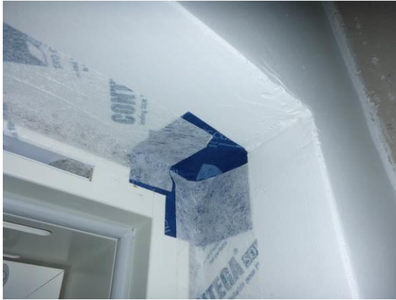
Kuva 4. Nurkkakappaleiden asentamisen jälkeen ikkunan sivuille asennettiin liitosnauhat limittäen ne noin 20-50 mm nurkkakappaleiden päälle.
