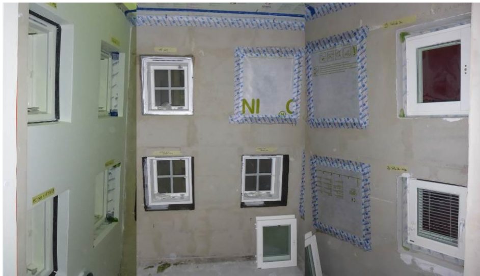
Kuva 9. Yleiskuva testirakennuksen sisäpuolelta ja liitosnauha-asennuksia.
