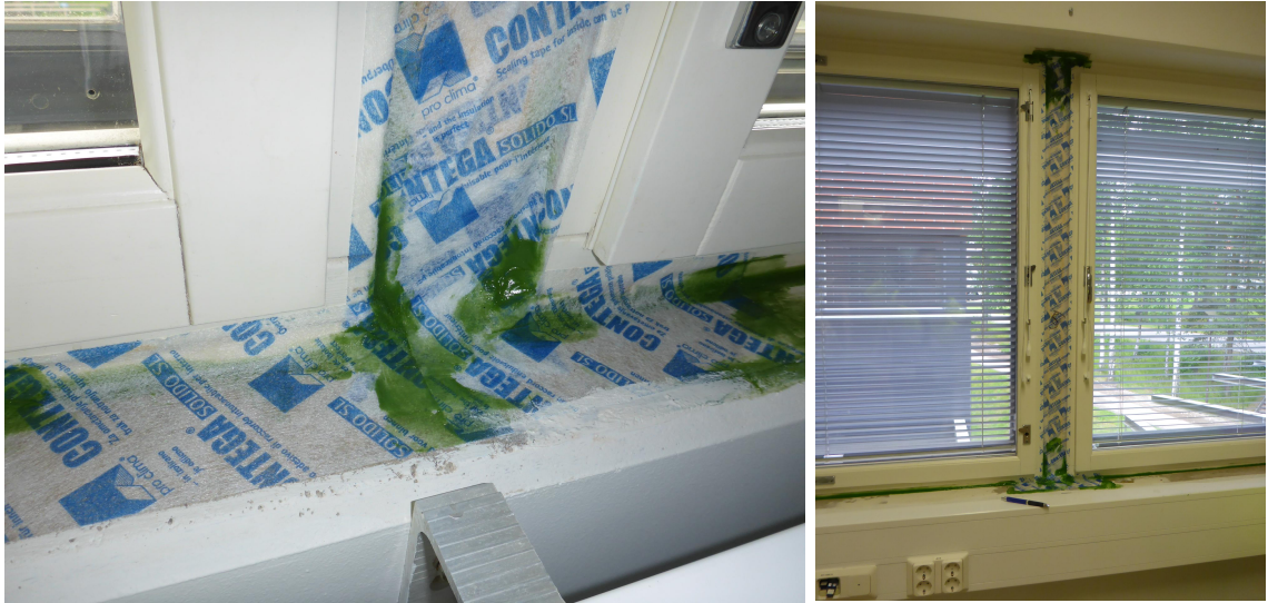
Kuva 18. Kuvan asennus on tehty siististi ja ikkunaliittymien ilmatiiviys on todennettu merkkiainetekniikalla. Liitosnauhojen limitys- ja taitoskohdat on tiivistetty huolellisesti nauhojen pintaan siveltävällä tiivistysmassalla. Liitosnauhat ovat hyvin kiinni alustassaan. Liitospinnat on puhdistettu ja ikkunapenkin betonipintaan on asennettu pohjusteaine ennen liitosnauhan asennusta. (kuvat: Sei Wha Vou, Vahanen Oy.)
