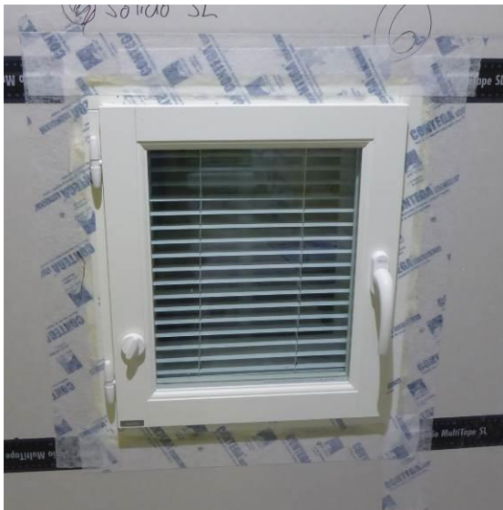
Kuva 1. Ikkunaliittymän tiivistys kipsilevyn pintaan toteutettuna Contega Solido SL –liitosnauhalla.
