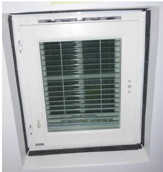
Kuva 1. Ikkunaliittymän tiivistys harkkorakenteisen seinän ikkuna-aukon pielen pintaan toteutettuna Illbruck ME500 –liitosnauhalla ja SP 525 -tiivistysmassalla.
