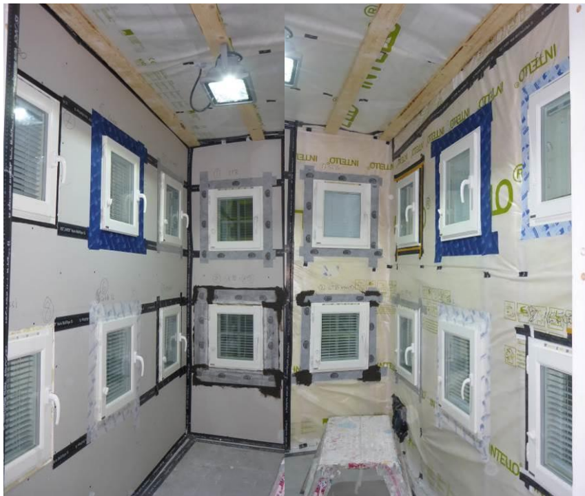
Kuva 6. Yleiskuva testirakennuksen sisäpuolelta ja liitosnauha-asennuksia.
