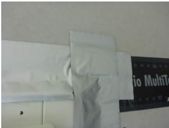
Kuva 6. Yhden nurkan osalla liitosnauha oli hieman poimuuntunut
