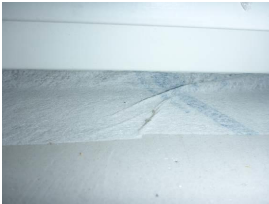
Kuva 6. Asennuksen yhteydessä havaittiin nauhan pinnan poimuuntuvan paikallisesti. Syntyneet poimut tasoittuivat painettaessa liitosnauhaa ikkunapielen pintaan
