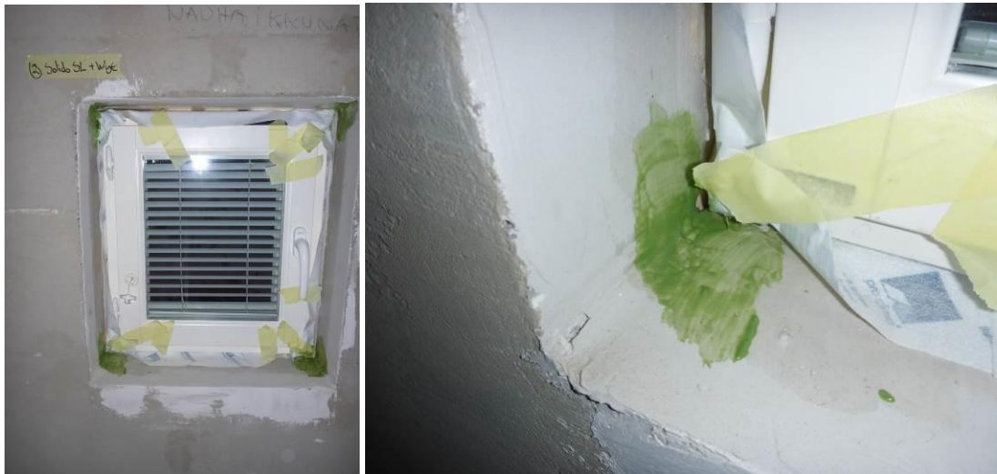
Kuvat 4 ja 5. Ikkuna-asennuksen jälkeen ikkunapielteen nurkkiin siveltiin Wyflexa – tiivistysmassaa ja tiivistysmassan kuivuttua liitosnauha asennettiin ikkunapielteen hienotasoitettuun ja Tescon Primer RP -pohjusteella käsitellyyn pintaan poistamalla ikkunapielen pintaan asennettavan liimapinnan suojapaperi koko nauhan matkalta
