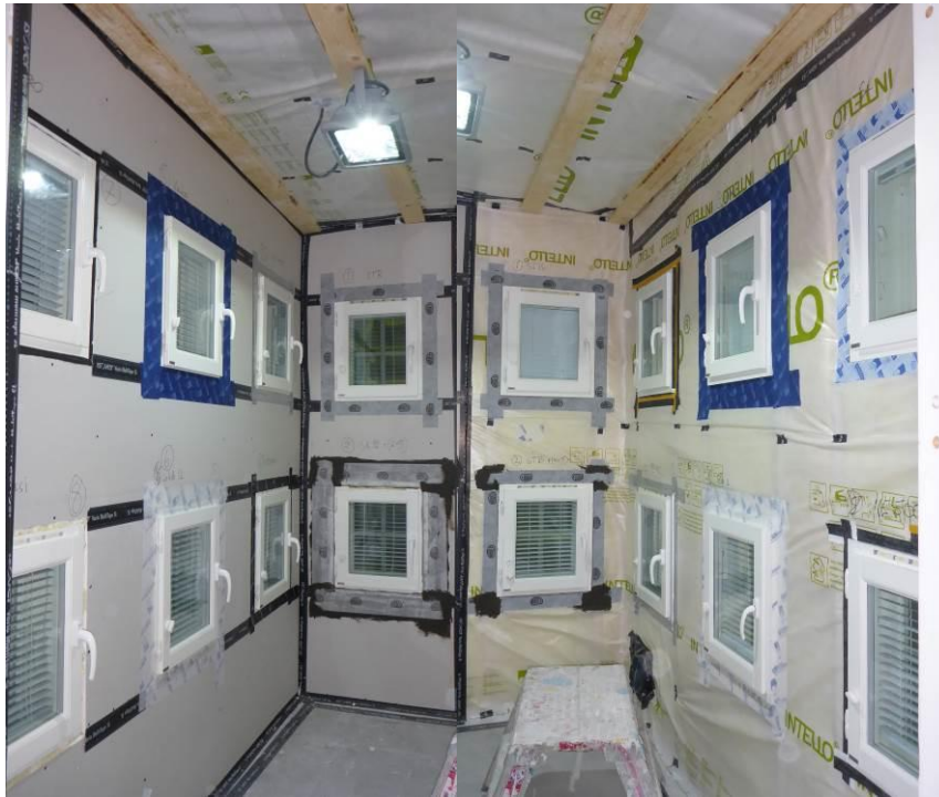
Kuva 5. Yleiskuva testirakennuksen sisäpuolelta ja liitosnauha-asennuksia.
