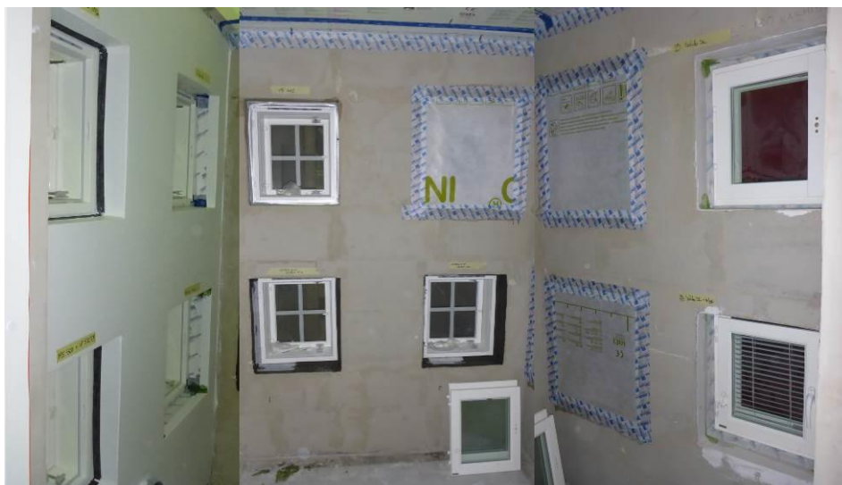
Kuva 9. Yleiskuva testirakennuksen sisäpuolelta ja liitosnauha-asennuksia.
