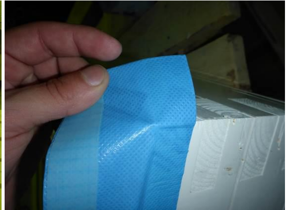
Kuvat 4 ja 5. Liitosnauhan asennus toteutettiin ensin ikkunan karmin sivupintaan, koko karmin ympäri ennen ikkunan asennusta. Ikkunan kulmiin tehtiin nauhalla noin 30-40mm:n taitos liitosnauhan liepeen nurkka-asennusta varten.
