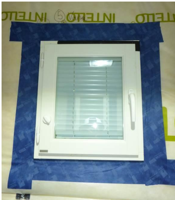
Kuva 1. Ikkunaliittymän tiivistys höyrynsulkukalvon pintaan toteutettuna Tescon Vana –yleisteipillä.
