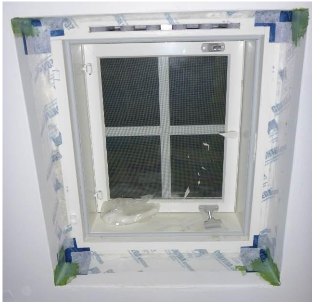
Kuva 1. Ikkunaliittymän tiivistys harkkorakenteisen seinän ikkuna-aukon pielten pintaan toteutettuna Contega Solido SL –liitosnauhalla.
