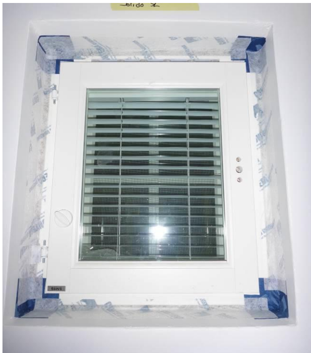
Kuva 1. Ikkunaliittymän tiivistys harkkorakenteisen seinän ikkuna-aukon pielten pintaan toteutettuna Contega Solido SL –liitosnauhalla.
