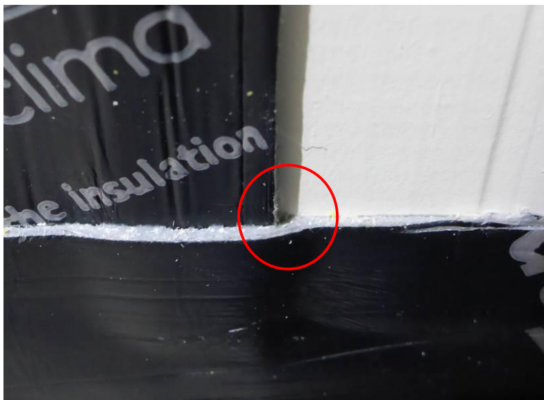
Kuva 6. Butyylinauhan havaittiin olevan irti alustastaan saumakohdissa, joissa eri sivujen nauhat limittyvät päällekkäin
