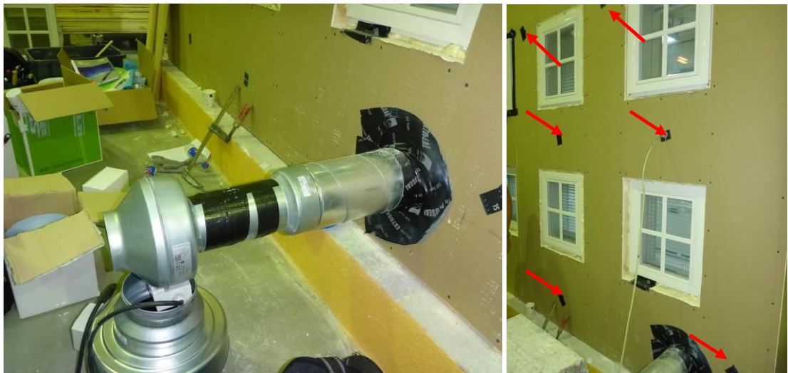
Kuvat 3 ja 4. Testijärjestely vasemmalla alipaineistukseen käytetty kanavapuhallin, oikealla merkkikaasun syöttöpisteitä ulkoseinärakenteessa.
