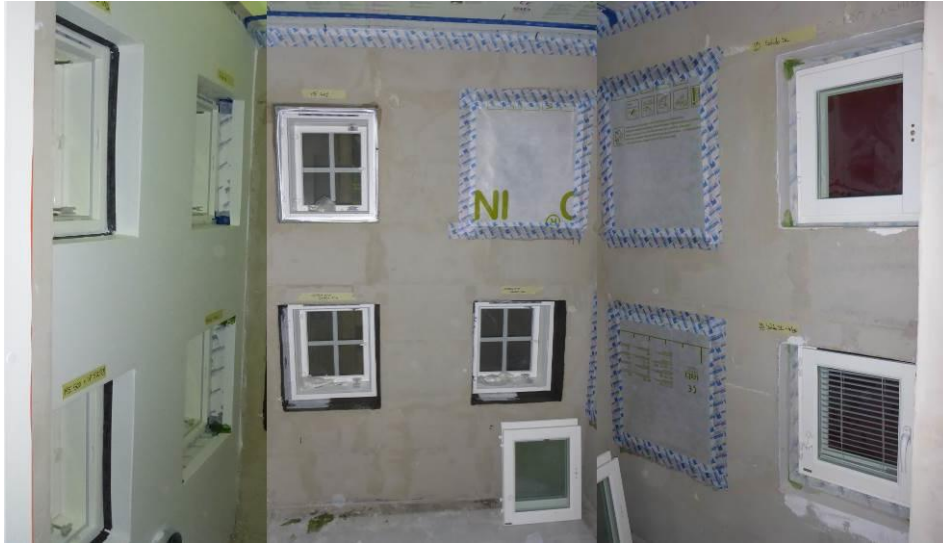
Kuva 8. Yleiskuva testirakennuksen sisäpuolelta ja liitosnauha-asennuksia.
