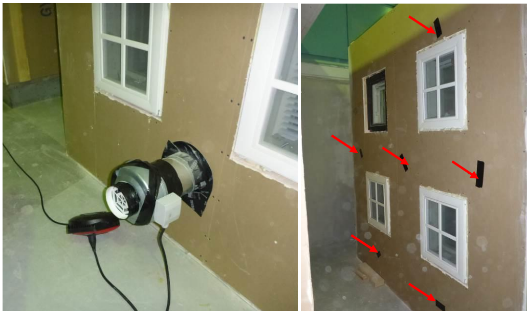
Kuvat 7 ja 8. Testijärjestely vasemmalla alipaineistukseen käytetty kanavapuhallin, oikealla merkkikaasun syöttöpisteitä ulkoseinärakenteessa.
