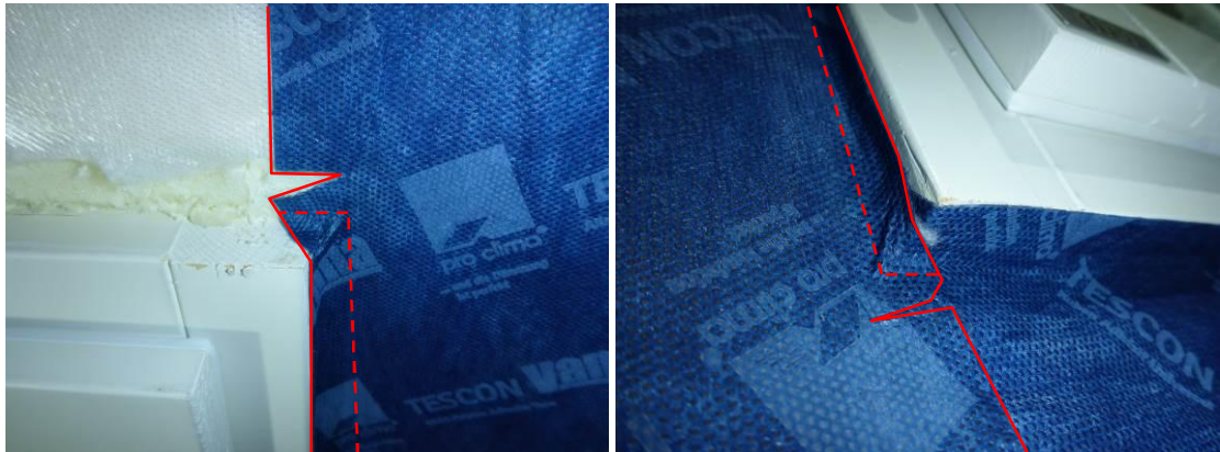
Kuvat 2 ja 3. Ikkunan nurkkaliitokset toteutettiin asentamalla eri sivujen nauhat ristiin taittaen nauhan liepeet päällekkäin leikkauskohdasta. Asennetun liitosnauhan reuna on merkitty kuvaan punaisella viivalla ja liitosnauhan taitos punaisella katkoviivalla.
