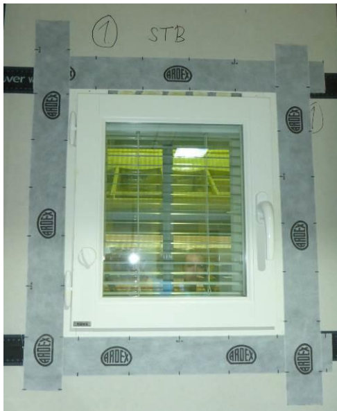
Kuva 1. Ikkunaliittymän tiivistys kipsilevyn pintaan toteutettuna Ardex STB 75-15 -karminauhalla
