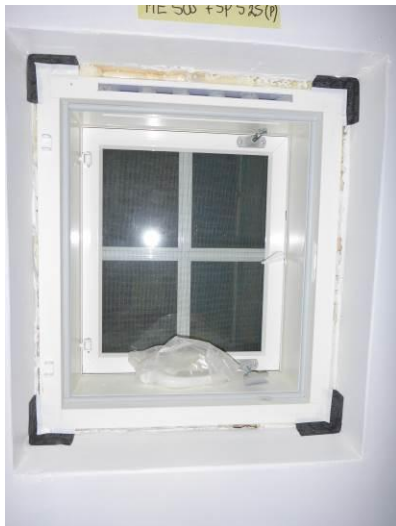
Kuva 3. Ikkunan nurkkaliitokset toteutettiin asentamalla nurkkakohtiin ME500 – liitosnauhasta taitetut nurkkakappaleet.
