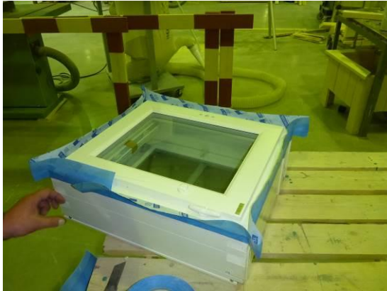
Kuvat 4 ja 5. Liitosnauhan asennus toteutettiin ensin ikkunan karmin sivupintaan, koko karmin ympäri ennen ikkunan asennusta. Ikkunan kulmiin tehtiin nauhalla noin 30-40mm:n taitos liitosnauhan liepeen nurkka-asennusta varten.
