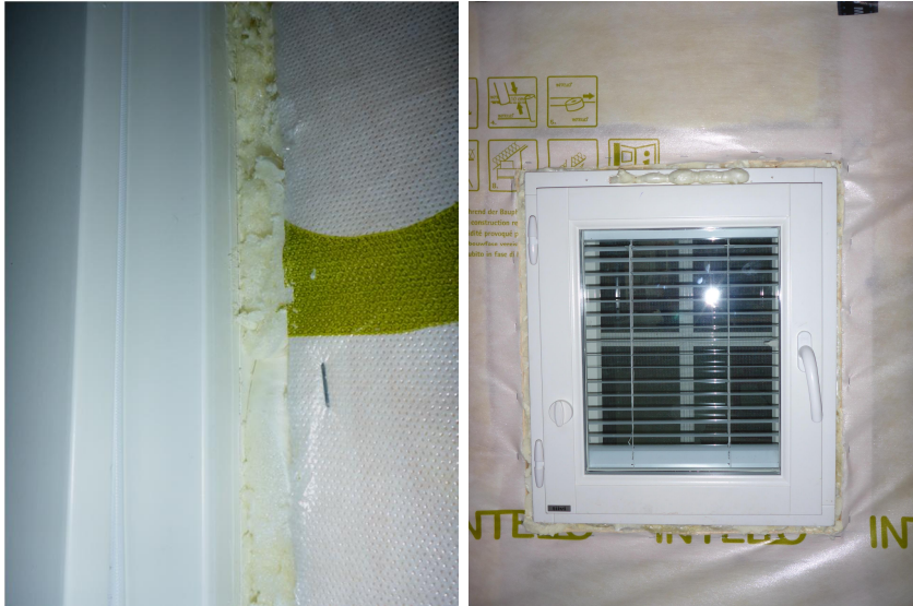
Kuva 36. Ikkunakarmin ja ulkoseinärakenteen välinen liittäminen ennen puhdistusta ja liitosnauha-asennuksia.
