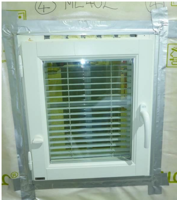
Kuva 1. Ikkunaliittymän tiivistys höyrinsulkukalvon pintaan toteutettuna Illbruck ME 402 –liitosnauhalla.
