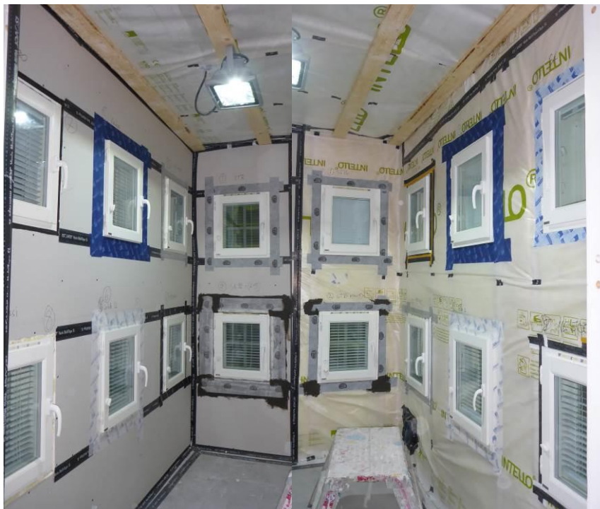
Kuva 7. Yleiskuva testirakennuksen sisäpuolelta ja liitosnauha-asennuksia.
