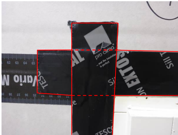
Kuva 2. Ikkunan nurkkaliitokset toteutettiin asentamalla eri sivujen nauhat ristiin, päällekkäin nurkkakohdissa. Asennetun liitosnauhan reuna on merkitty kuvaan punaisella viivalla ja liitosnauhan limitys punaisella katkoviivalla.
