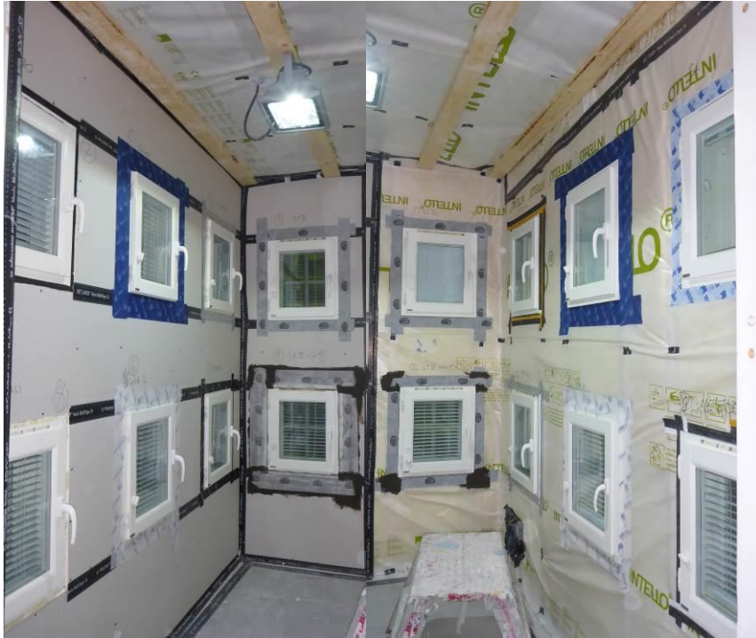
Kuva 5. Yleiskuva testirakennuksen sisäpuolelta ja liitosnauha-asennuksia.
