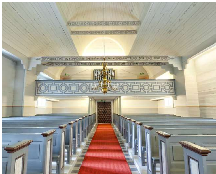
KUVA 15. Sisäkuvasta voidaan havaita sisäpuolella näkyvät tukipilarit, sidehirret ja lankkuseinärakenne (Ylöjärven seurakunta, Aurejärven kirkko)
