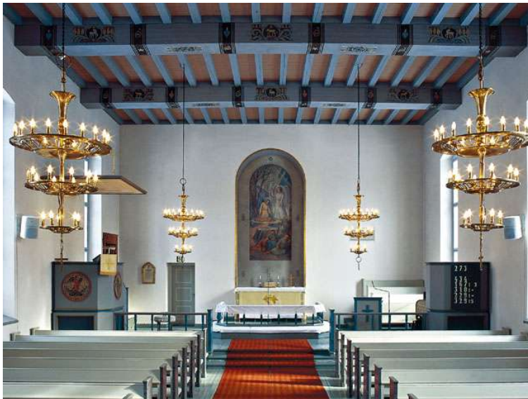
KUVA 38. Pohjaslahden kirkon kirkkosalissa näkyvät yläpohjan betonipalkit (Geocaching 2016)
