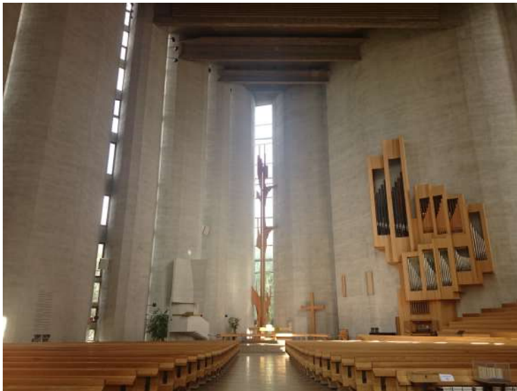
KUVA 45. Kalevan kirkon liukuvaletut seinät sekä kattopalkisto (Kuva: Riina Kangasluoma 2016)
