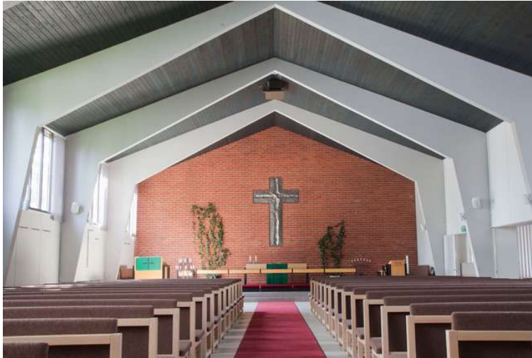
KUVA 50. Härmälän kirkon kirkkosalissa huomio kiinnittyy jyrkeviin kolminivelkehiin (Tampereen seurakuntayhtymä, Härmälän kirkko)
