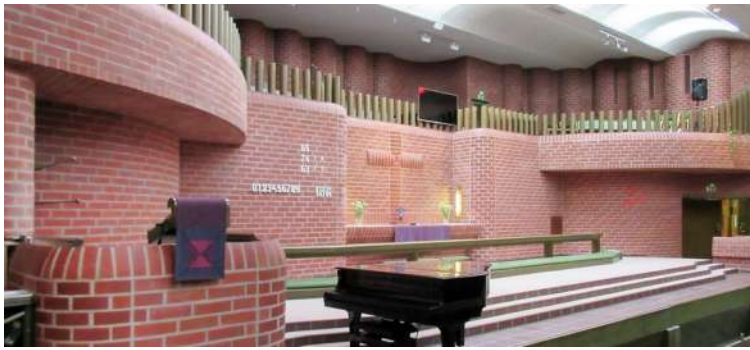
KUVA 52. Pyöreitä muotoja saadaan aikaan taitavalla tiilimuurauksella. Kuvassa Hervannan kirkko (Rehau, Unlimited Polymer Solutions)
