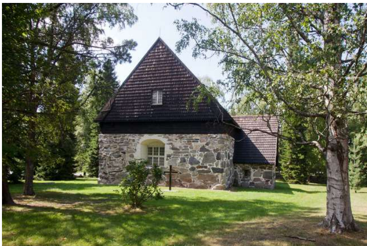
KUVA 10. Messukylän kirkon katto ja päädyt ovat samaa paanutettua pintaa (Tampereen seurakuntayhtymä, Messukylän vanha kirkko)
