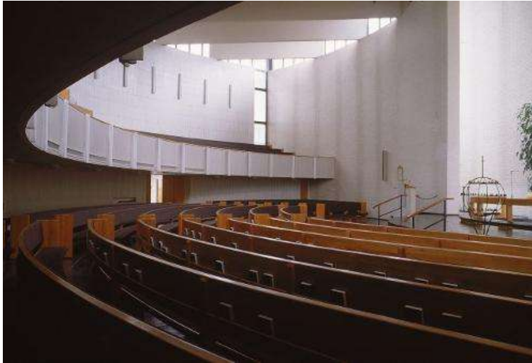
KUVA 44. Oriveden kirkon kaarevat seinät ja niiden päälle kiinnitetyt kattopalkit (Mu-seot Online, Orivesi, kirkko)
