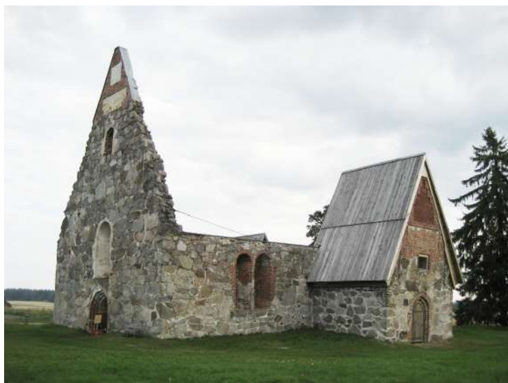
KUVA 9. Kirkko on raunioitunut, mutta kirkon suojelemiseksi perustettu Pälkäneen Vanhankirkon Suojeluyhdistys ry pitää rapautumisen kurissa. Kuvassa asehuoneen uusi lautakatto (Kuva: Riina Kangasluoma 2015)
