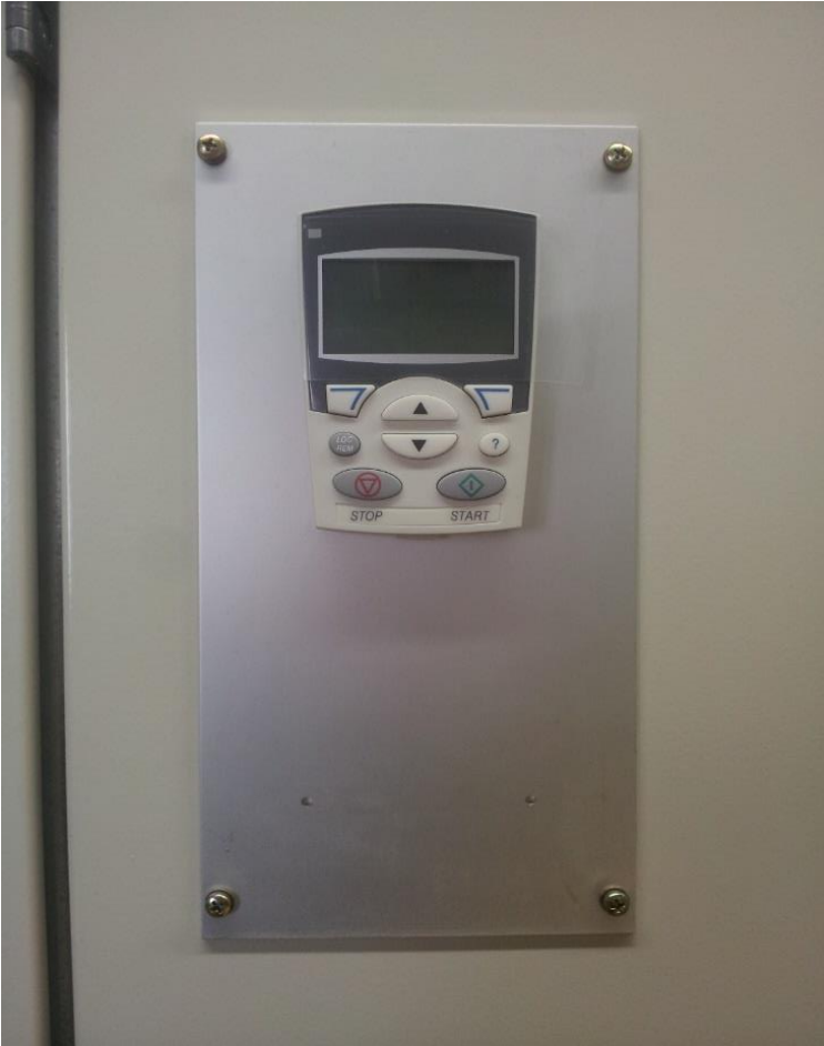
KUVA 6. DCS 800 -suuntaajan ohjauspaneeli
