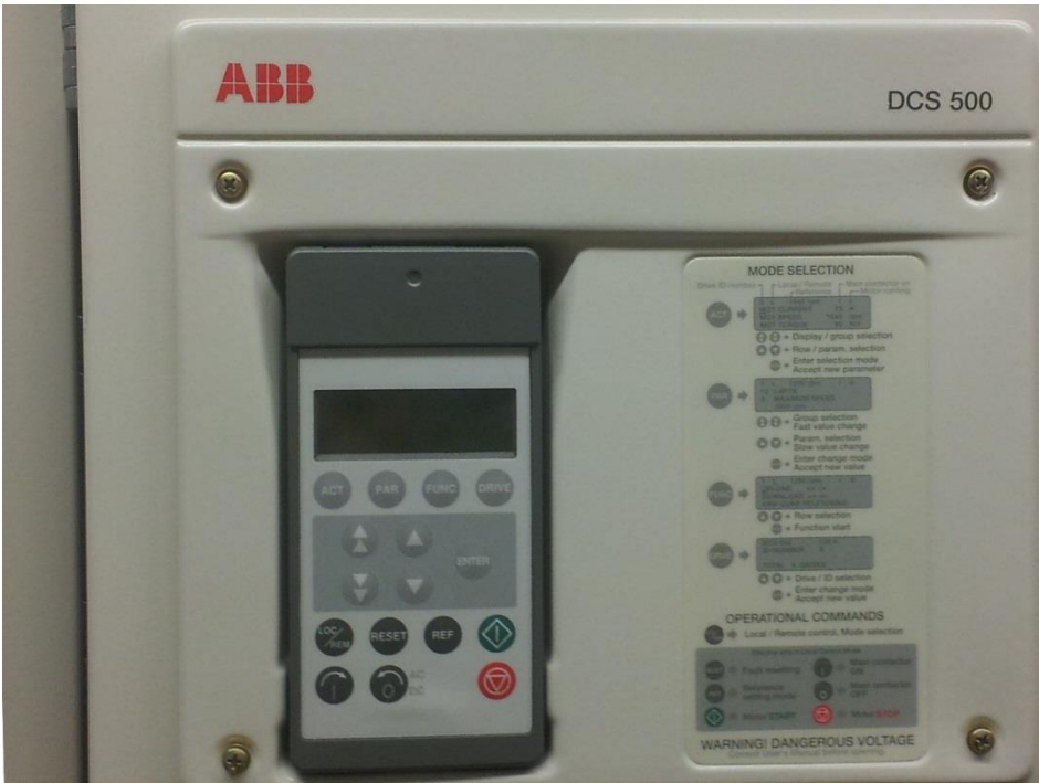
KUVA 5. DCS 500 -suuntaajan ohjauspaneeli
