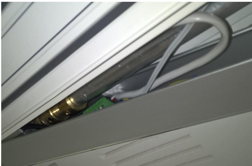
Kuva 2: Kytkinriman ja johdotuksen ahtaus
