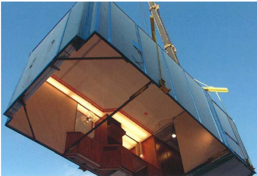
Kuva 4. Moduulirakenteisen elementin siirto asennuskohteeseen (Immonen 2015)
