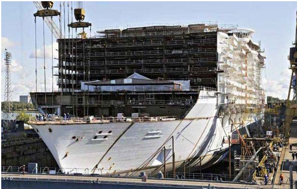
Kuva 1. Laivanrakennus runkovaiheessa (Talouselämä 2015)
