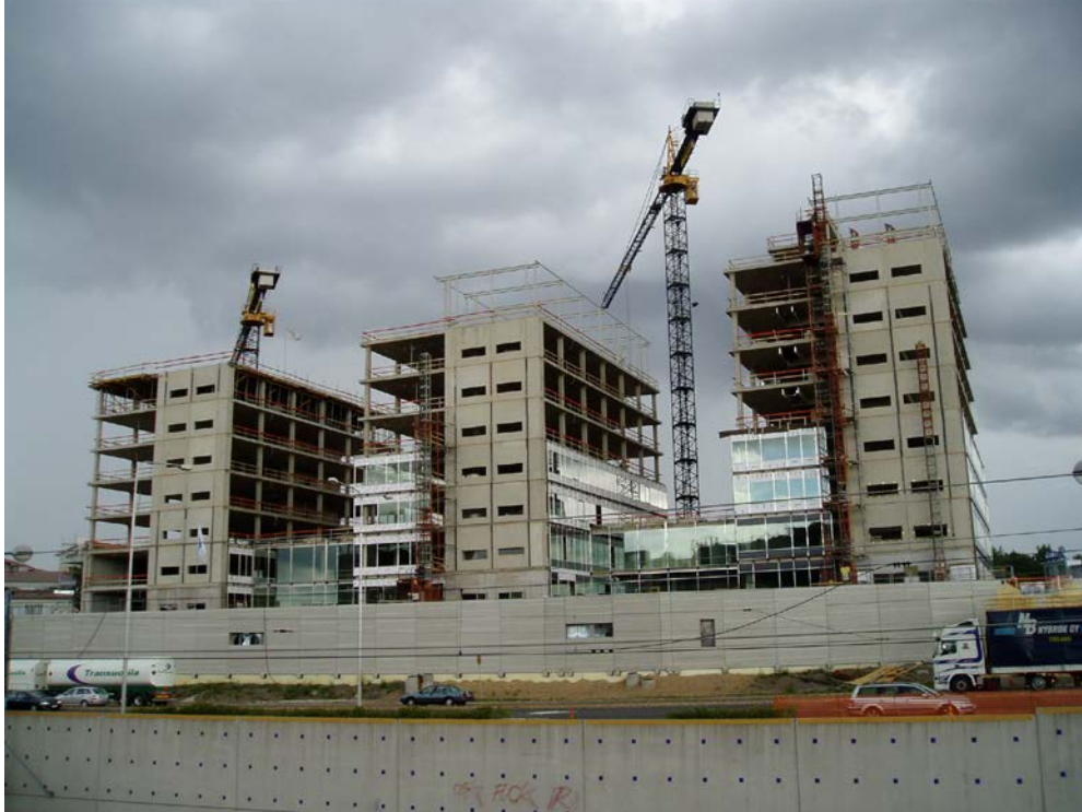
Kuva 5. Talonrakennustyömaa runkovaiheessa (Turunen 2002)
