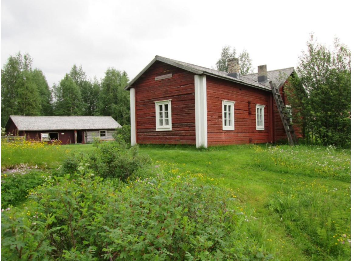
Kuva 5. Kallioniemi kuvattuna saunapolulta taustallaan navetta ja Museopuoti (kuva Riitta-Liisa Huttu)
