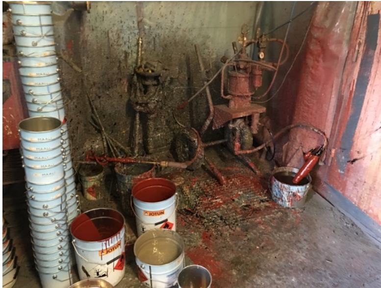
Kuva 12. Maalaamon tekninen tila projektin alussa.
