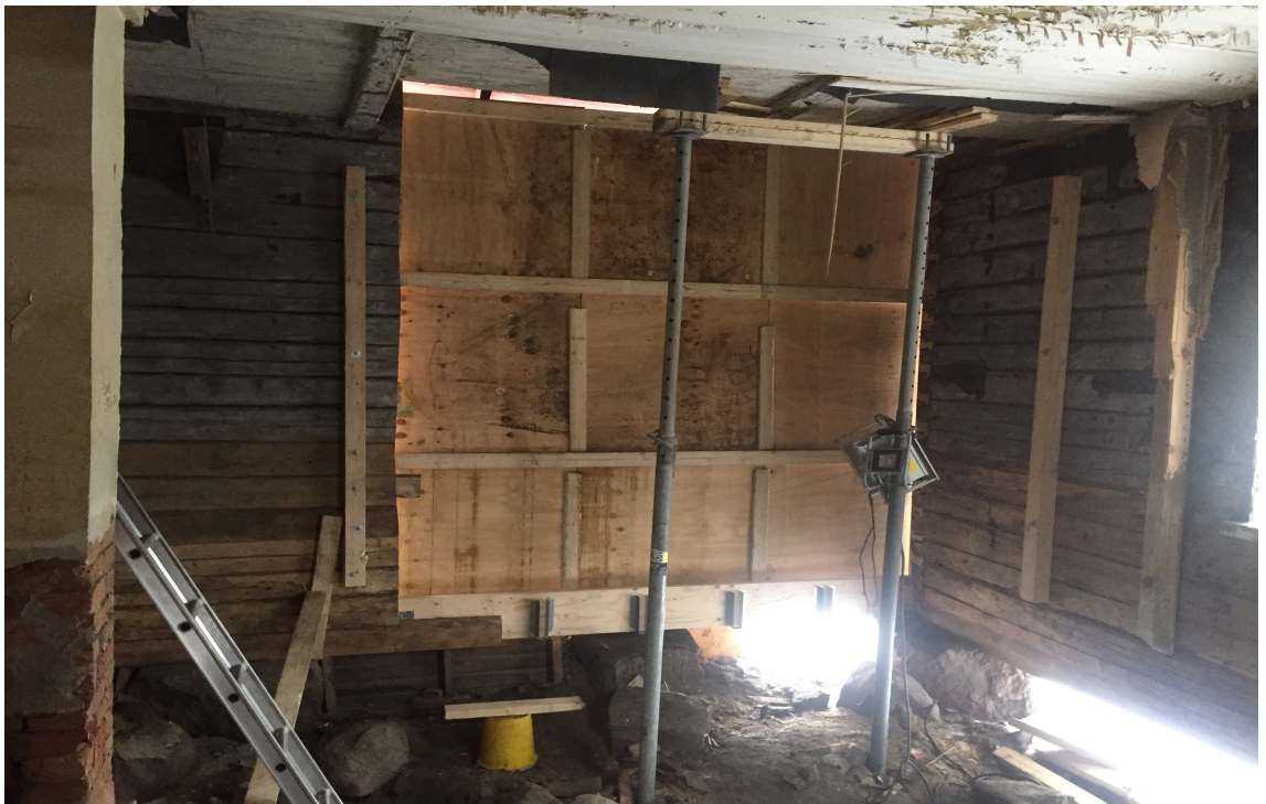
Kuva 5. Sudenkatu 3 Näkinmökin alapohja- ja seinärakenteita
