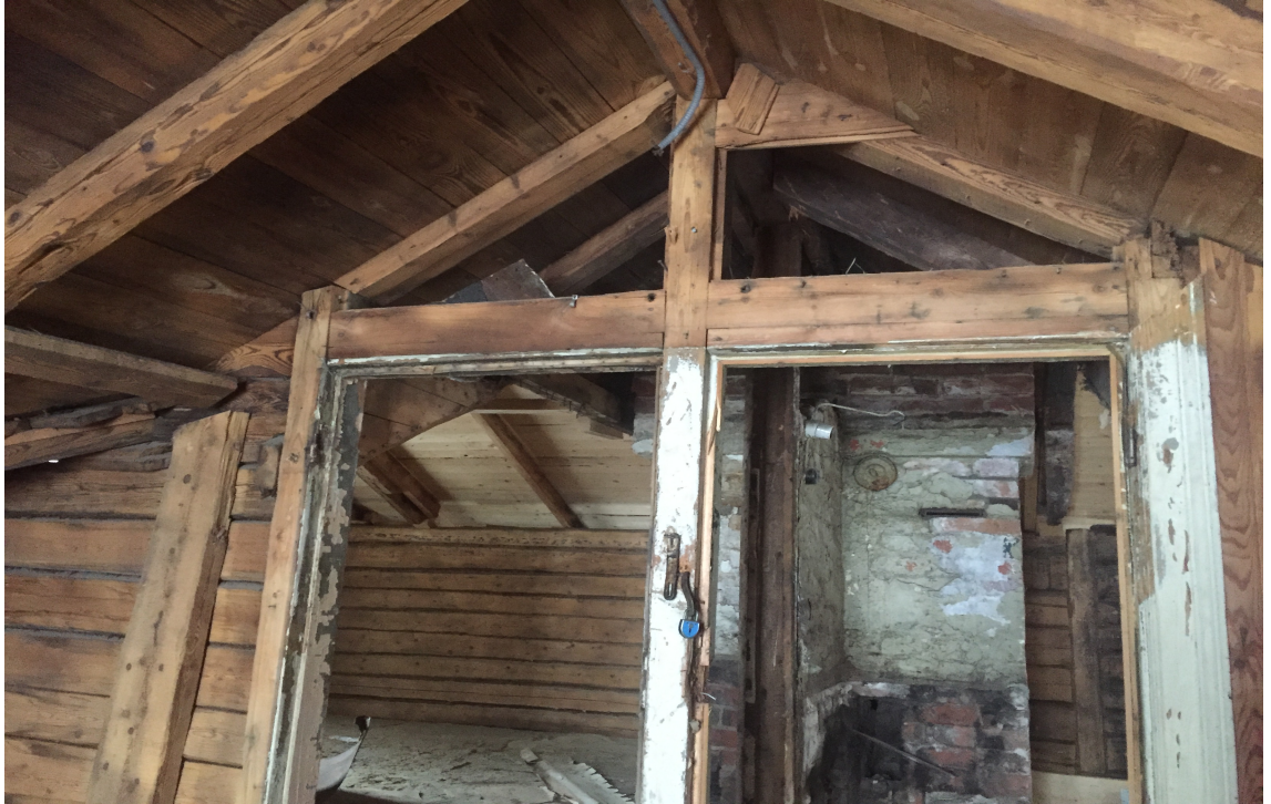
Kuva 4. Sudenkatu 3 Näkinmökin runkorakenteita
