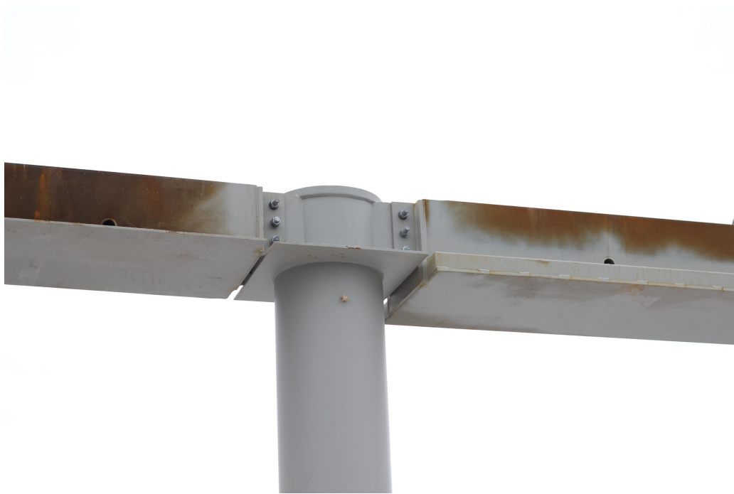
Kuva 46. WQ-palkin ja liittopilarin välinen kannakelevyliitos
