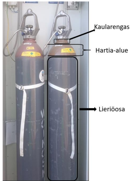
Kuva 2. Kaasupullojen rakenne, esimerkkinä helium N46.
