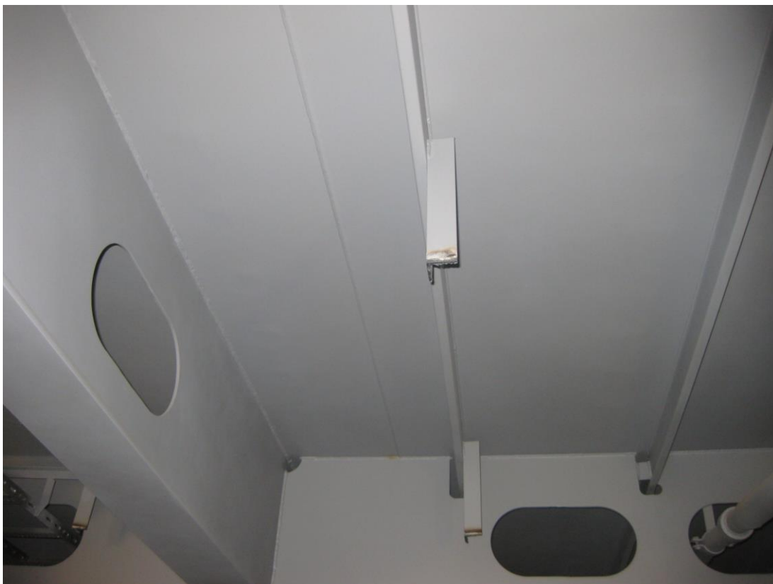
Kuva 2. Katkaistu kattokiinnike
