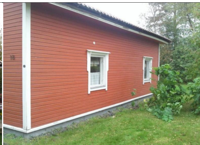
24. Julkisivua takapihan puolelta
