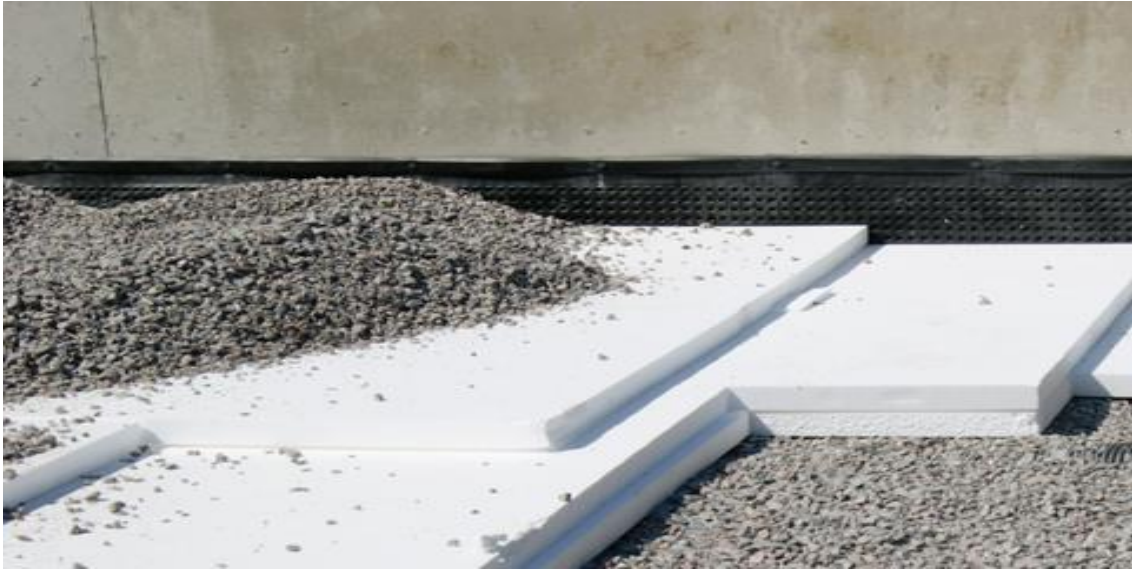
KUVA 5. Routasuojaus levyjen asennus (9)
