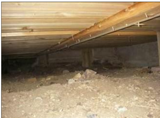
7. Näkymä alapohjatilaan keittiön viereisen makuuhuoneen päädyn puoleisesta tuuletusaukosta.
