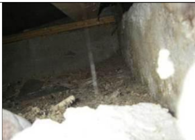
6. Näkymä alapohjatilaan takapihan puolelta suuremmasta tuuletusaukosta.
