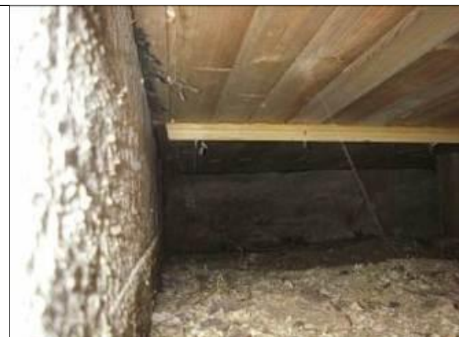
8. Näkymä alapohjatilaan keittiön viereisen makuuhuoneen päädyn puoleisesta tuuletusaukosta.
