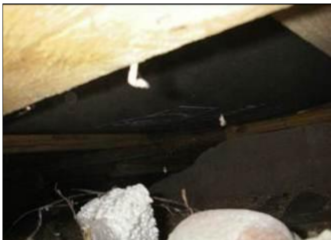
5. Näkymä alapohjatilaan takapihan puolelta suuremmasta tuuletusaukosta.
