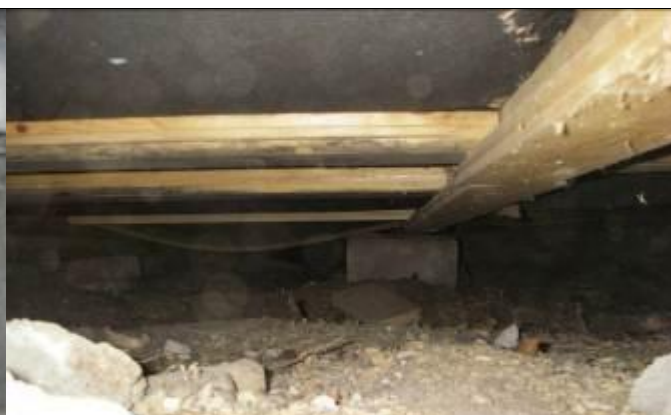
2. Näkymä alapohjatilaa olohuoneen kohdalla rakennuksen päädystä.
