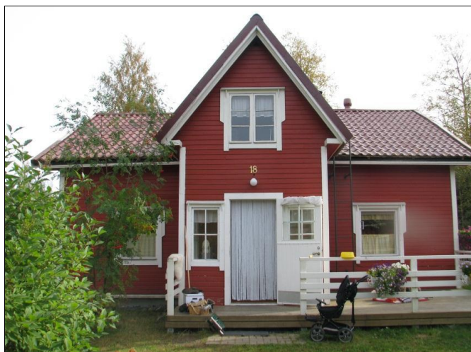
23. Julkisivua etupihan puolelta
