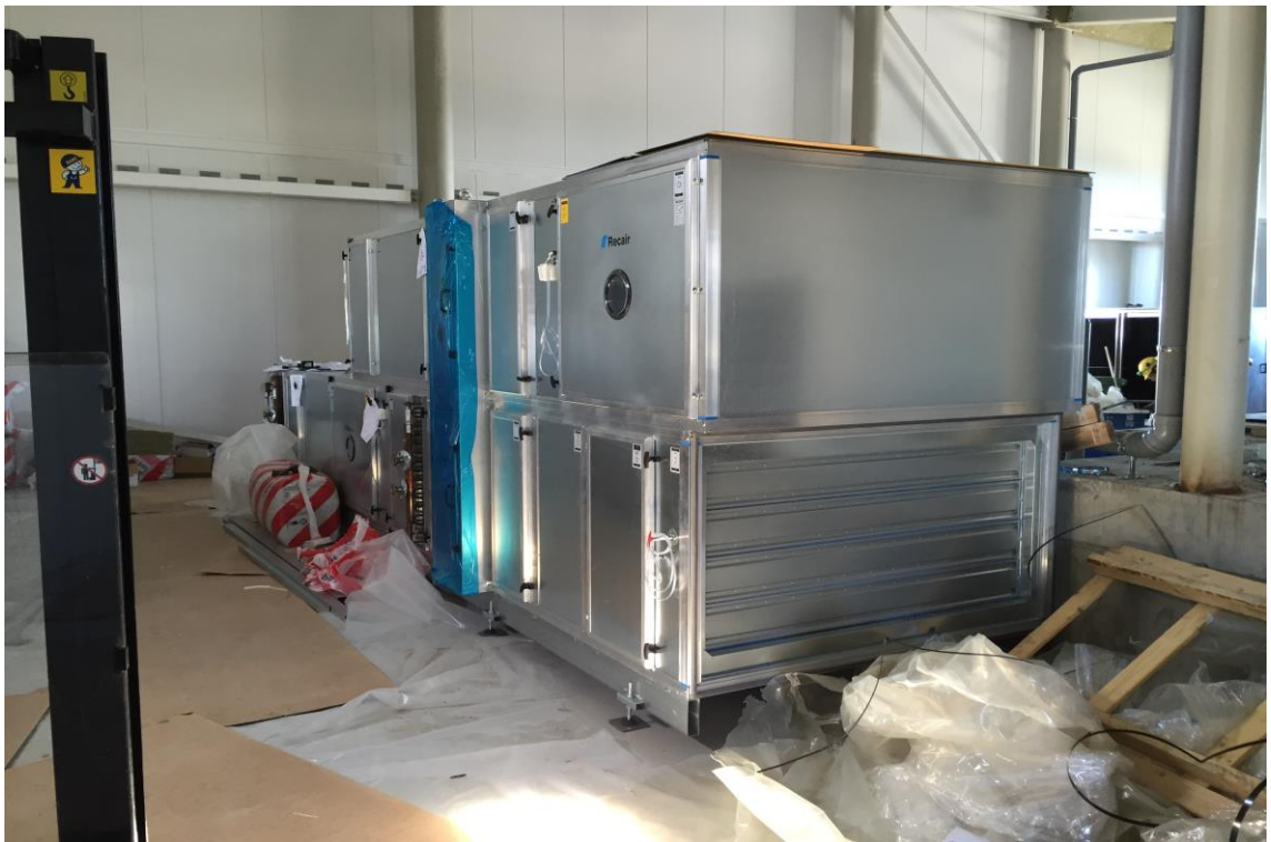
Kuva 14. Kuvassa Recairin palakone asennettuna konealustan päälle
