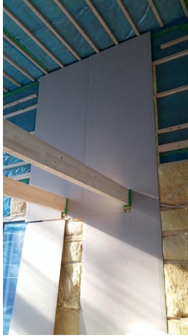
Kuva 17. Seinän levytys tulisijan kohdalta.
