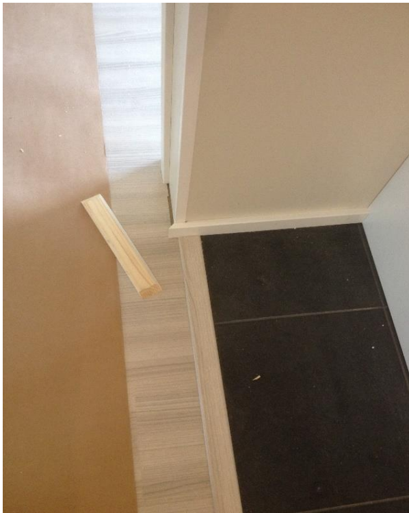
Kuva 29. Laatoituksen lista.
