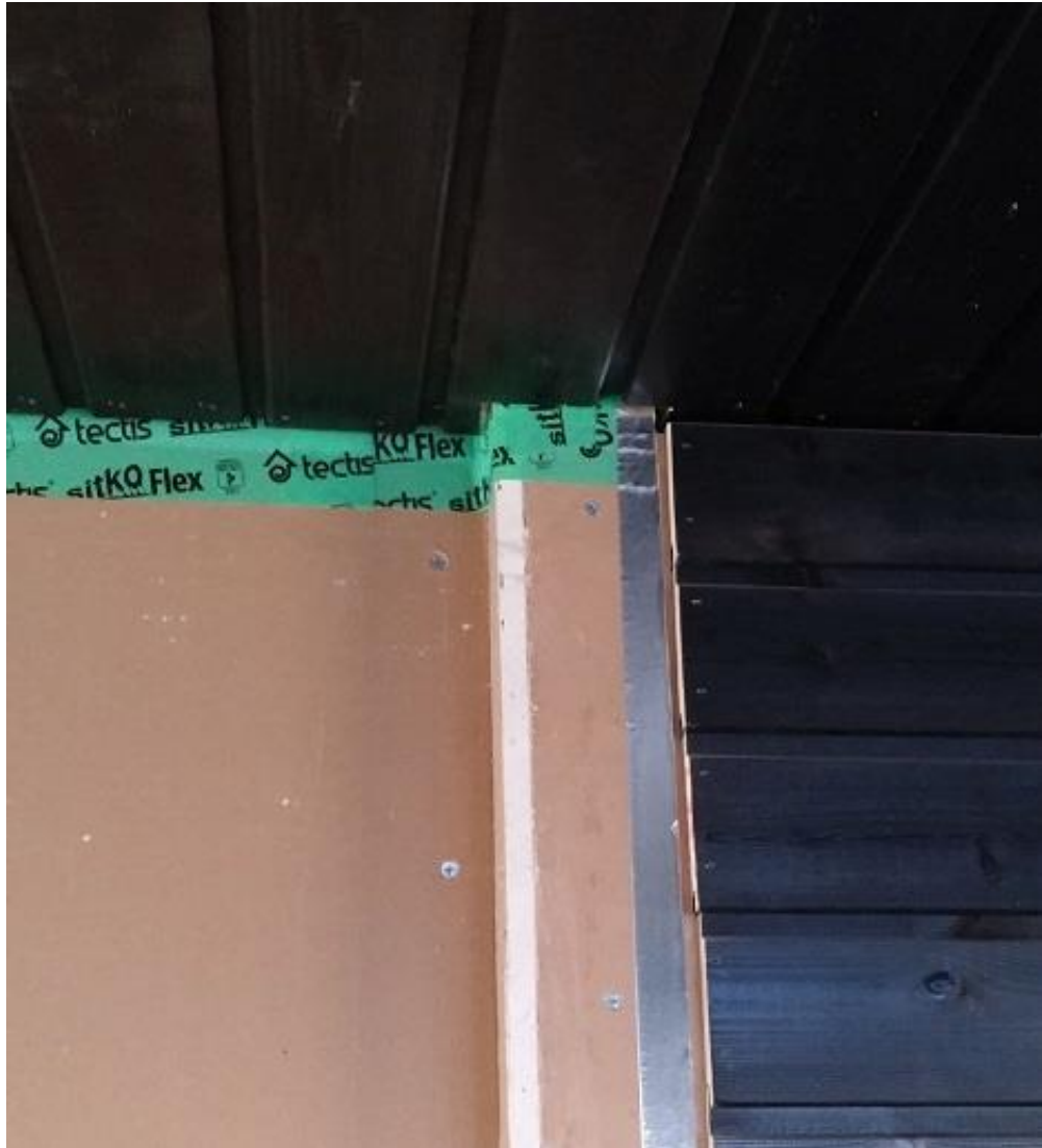
Kuva 23. Höyrynsulkuteipin ja alumiinipaperin limitys.
