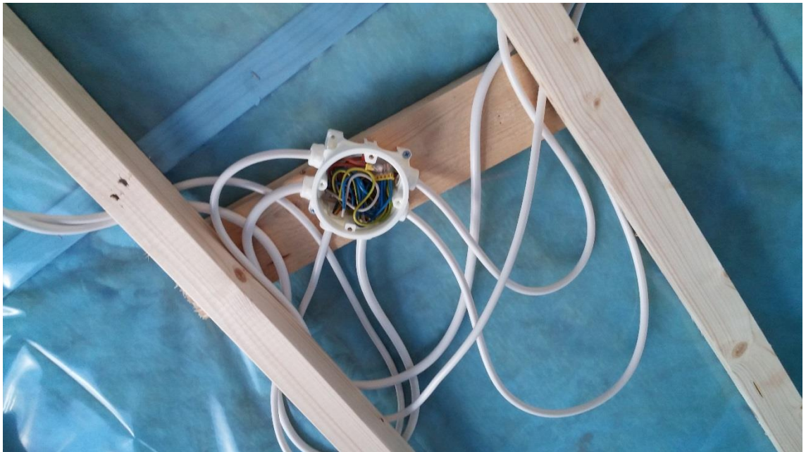
Kuva 16. Rasian kiinnitys.
