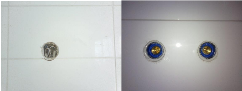
Kuva 28. Rasian reiät leikattu.
