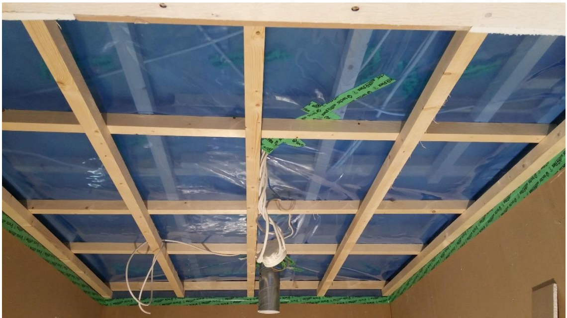
Kuva 25. Pesuhuoneen katto valmiina paneloitavaksi.
