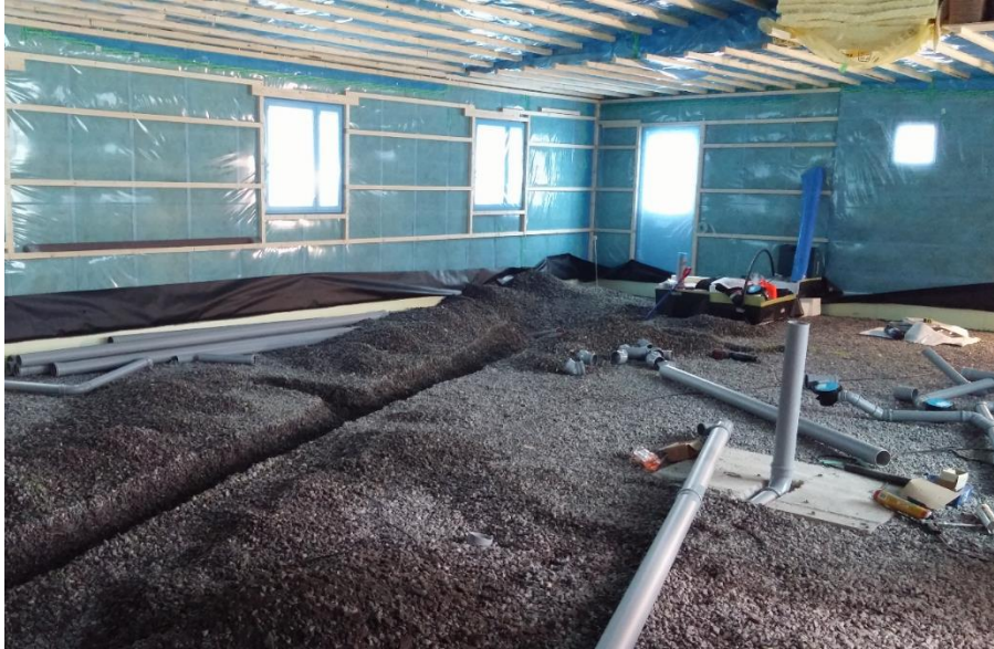
Kuva 6. Viemäreiden asennus.
