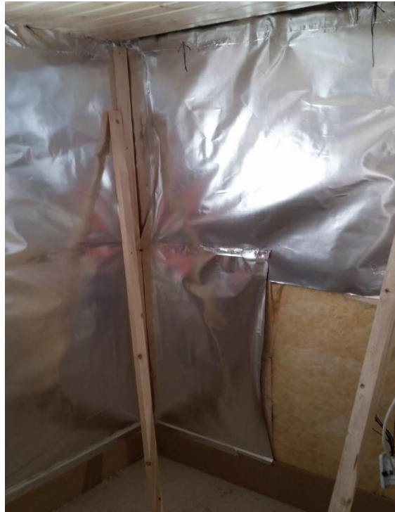
Kuva 22. Katto paneloitu ja alumiinipaperin asennus kesken.
