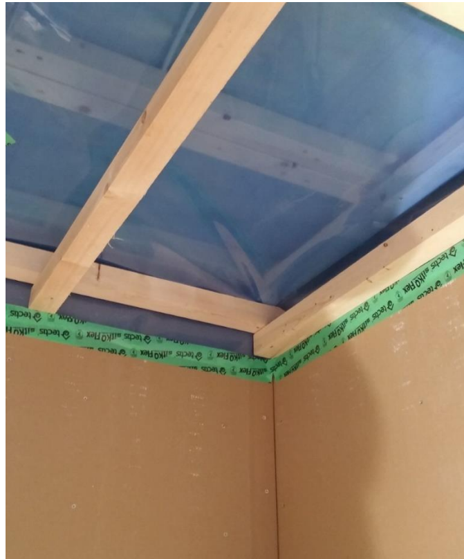
Kuva 24. Pesuhuoneen katto valmiina paneloitavaksi.
