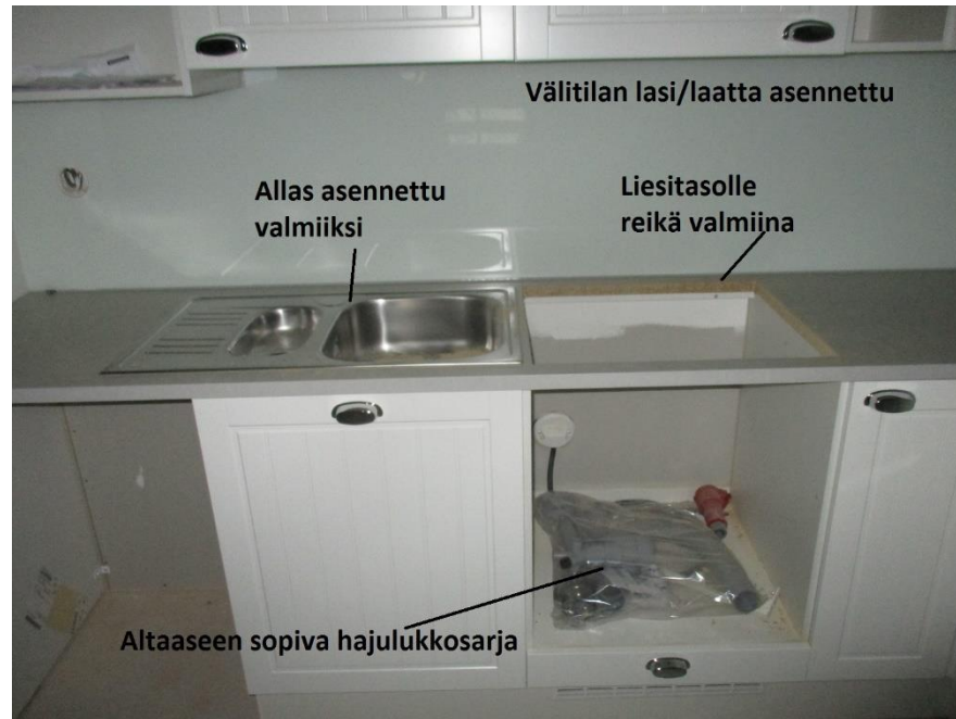
Kuva 31. Keittiön kalustus tehty.
