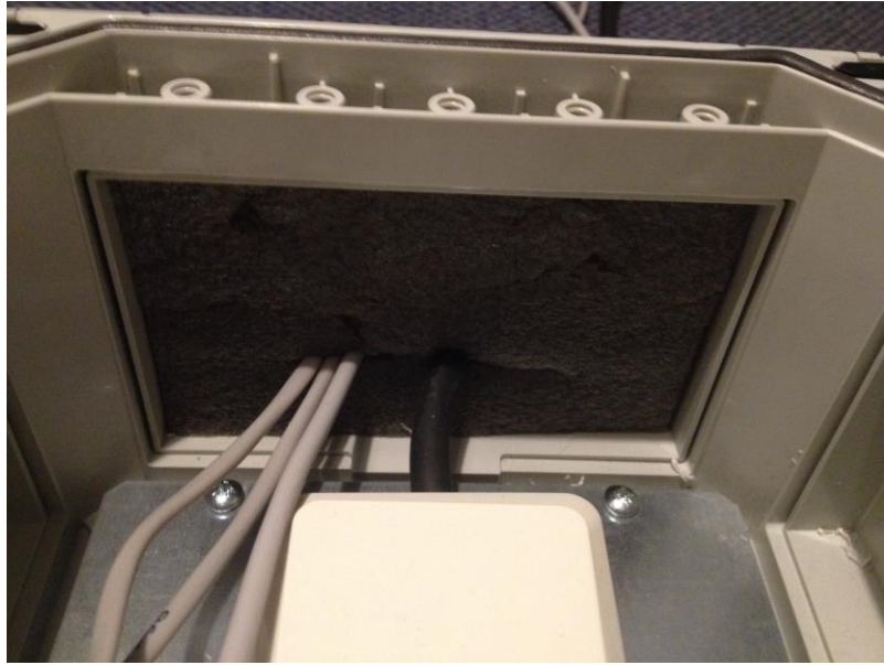
Kuva 30. Kaapelien läpivienti kotelosta ulos.
