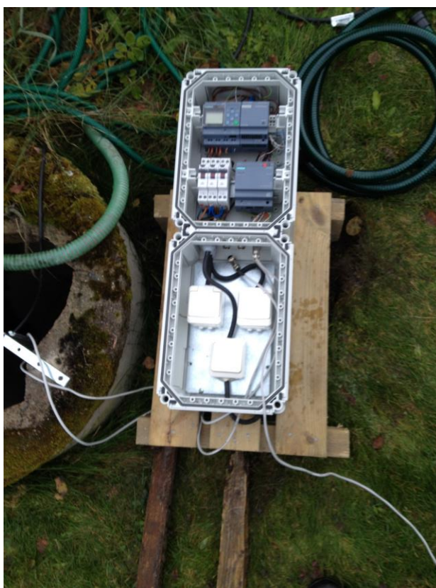
Kuva 46. Anturien ja moottorin kiinnitys automaatiokeskukseen.
