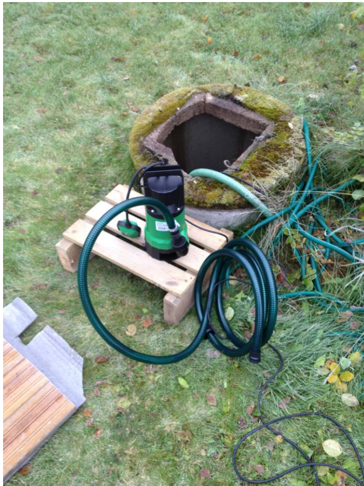
Kuva 38. Pumppu koekentällä marraskuun 2016 alussa valmiina asennettavaksi kaivoon.
