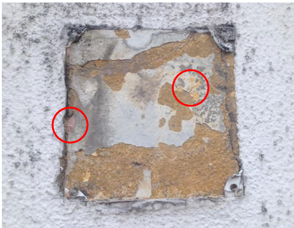
Kuva 12. Ulkoseinässä nähtävät värikerrokset. Kuvassa ympyröitynä vasemmalla vaaleanpunainen kerros, oikealla vaaleankeltainen. (Immonen 2016, muutokset kuvaan Hyttinen 2016)
