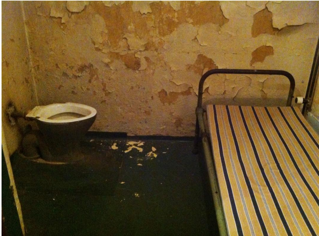
Kuva 17. Putkaan on jätetty wc-istuin, pesuallas ja heteka (Hyttinen 2015)
