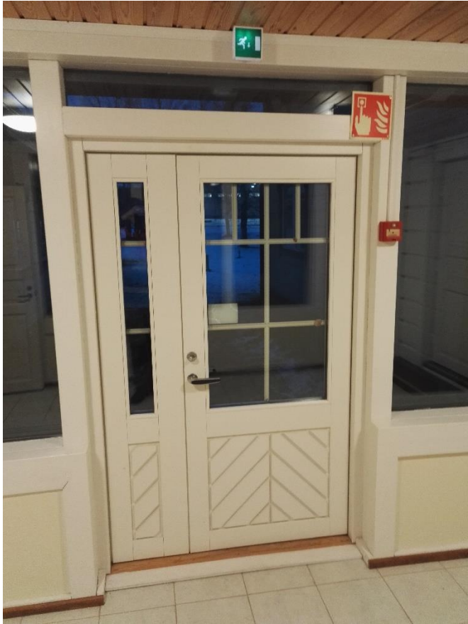
Kuva 4. Hälytyslaitteen ja hätäpoistumistien merkinnät toimistorakennuksessa.
