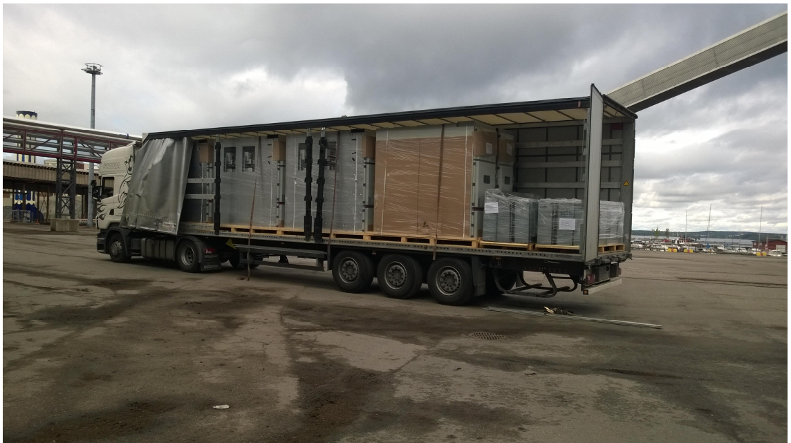
Kuva 5. 20 kV kojeisto saapui Tampereelle
