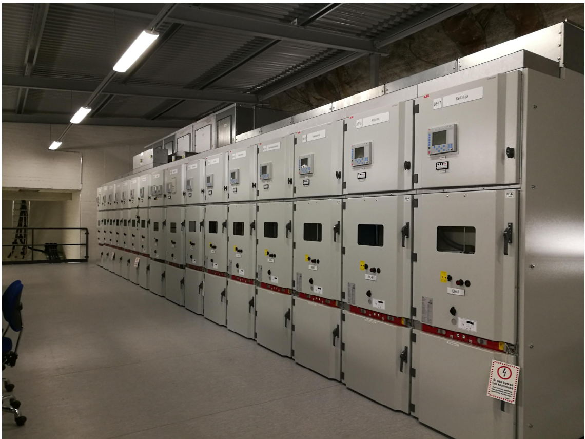
Kuva 14. Naistenlahden 20 kV kojeisto käytössä
