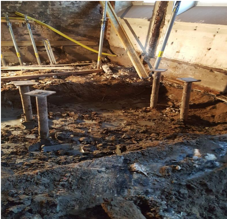
KUVA 9. Kellarin anturalinja kaivettuna
