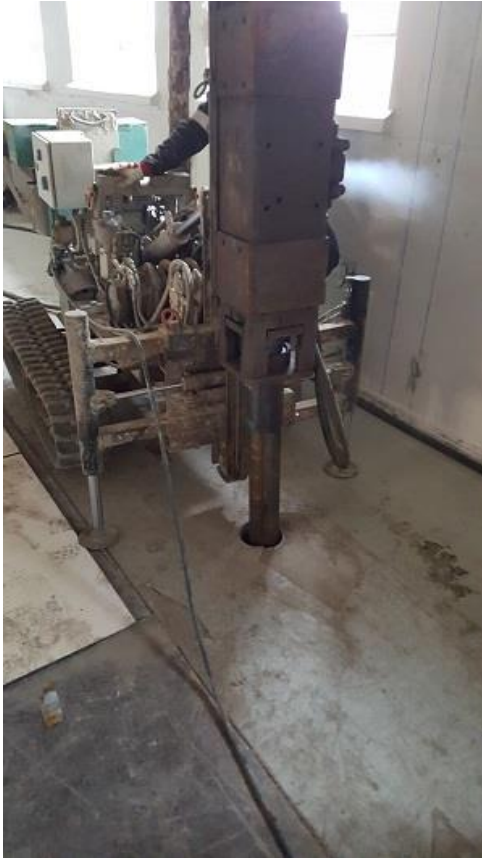
KUVA 3. Paalutuskone
