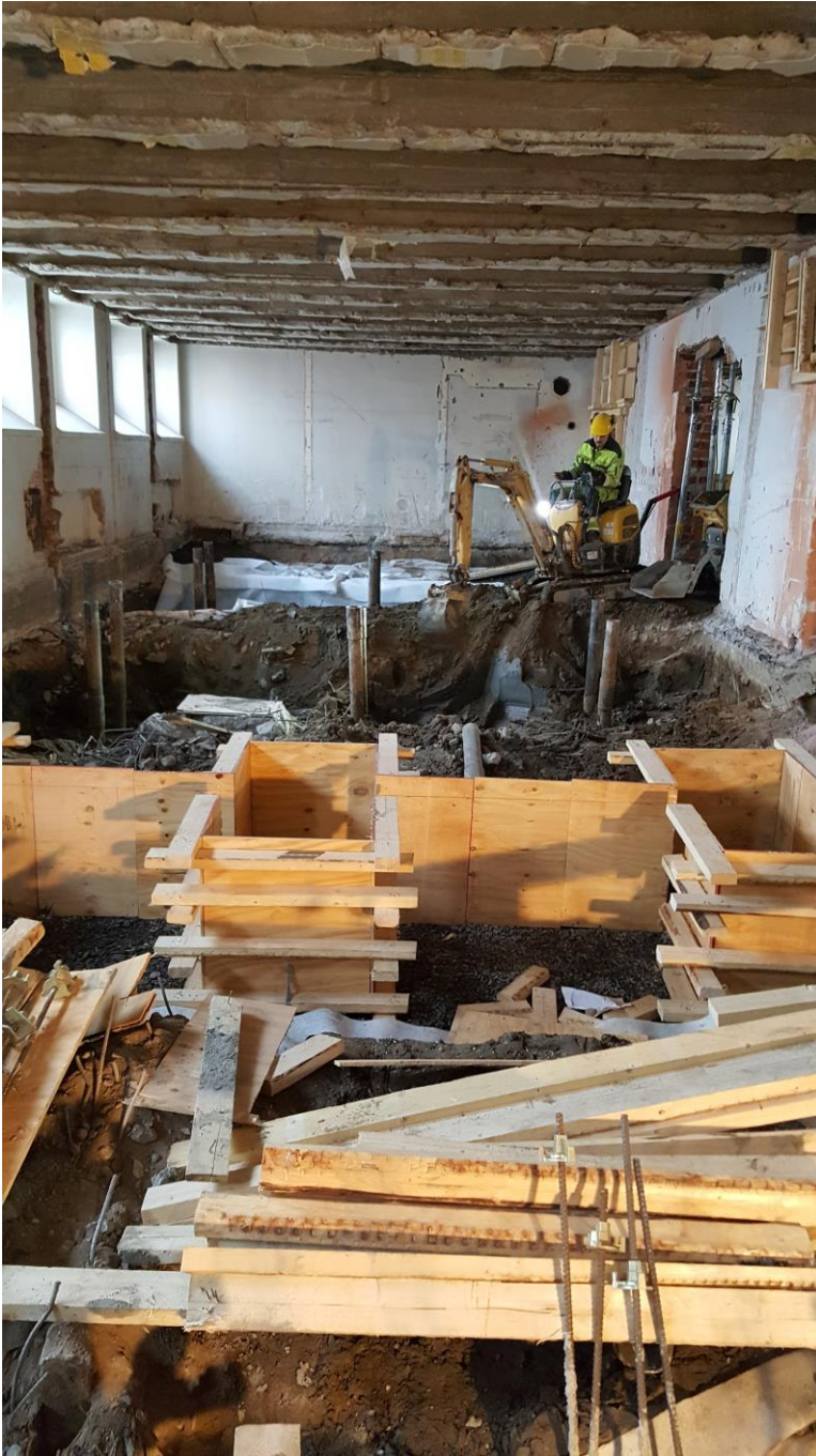
KUVA 14. Muottityötä
