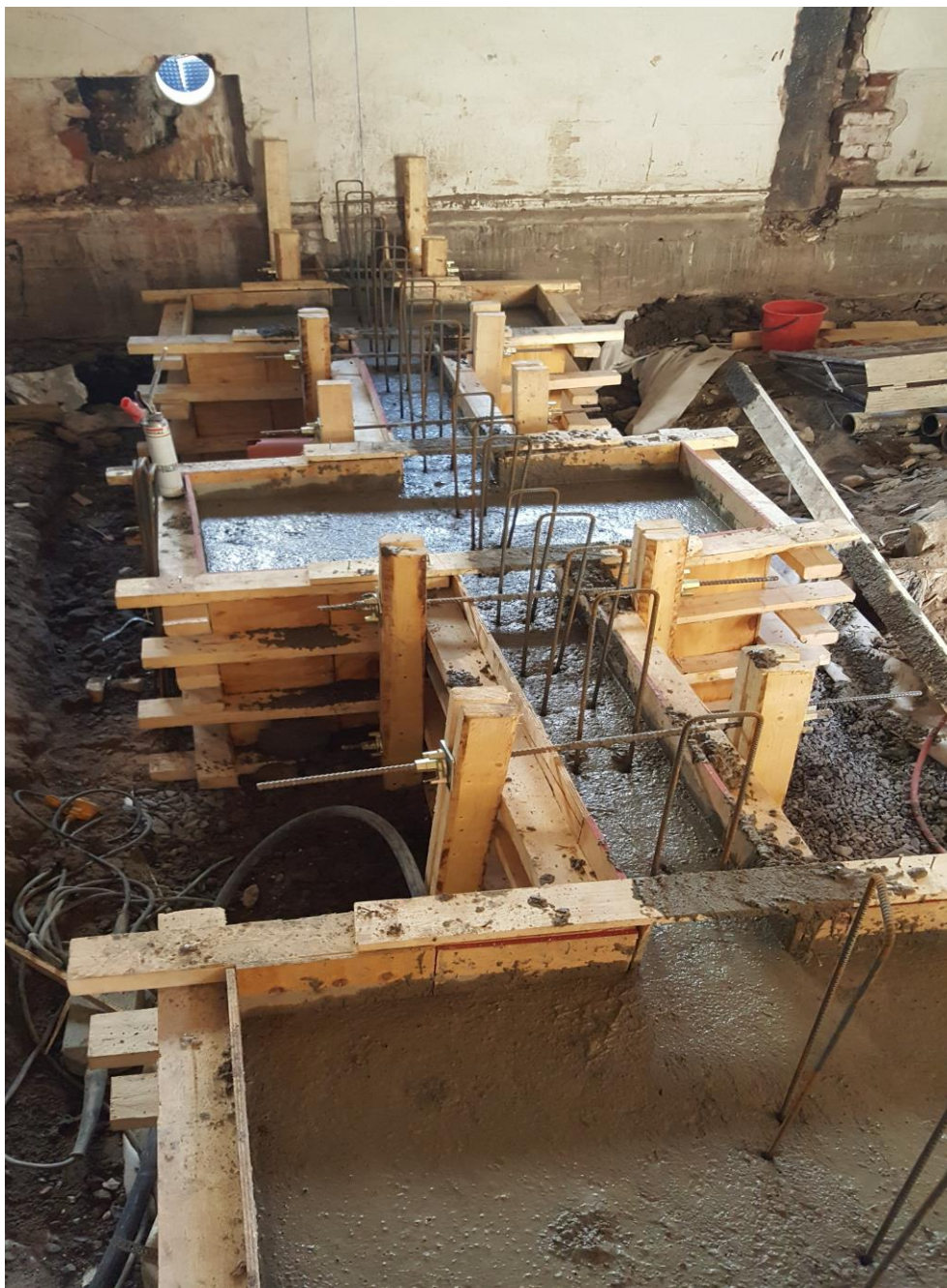
KUVA 15. Anturalaatikot valun jälkeen
