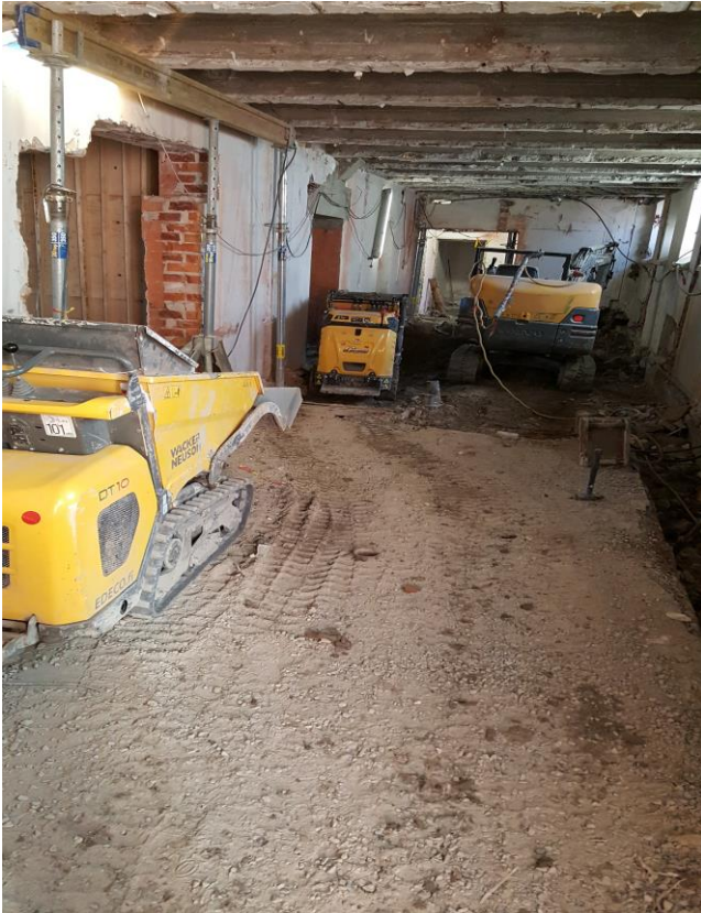
KUVA 7. Purukone ja purkujätteen kuljettimia
