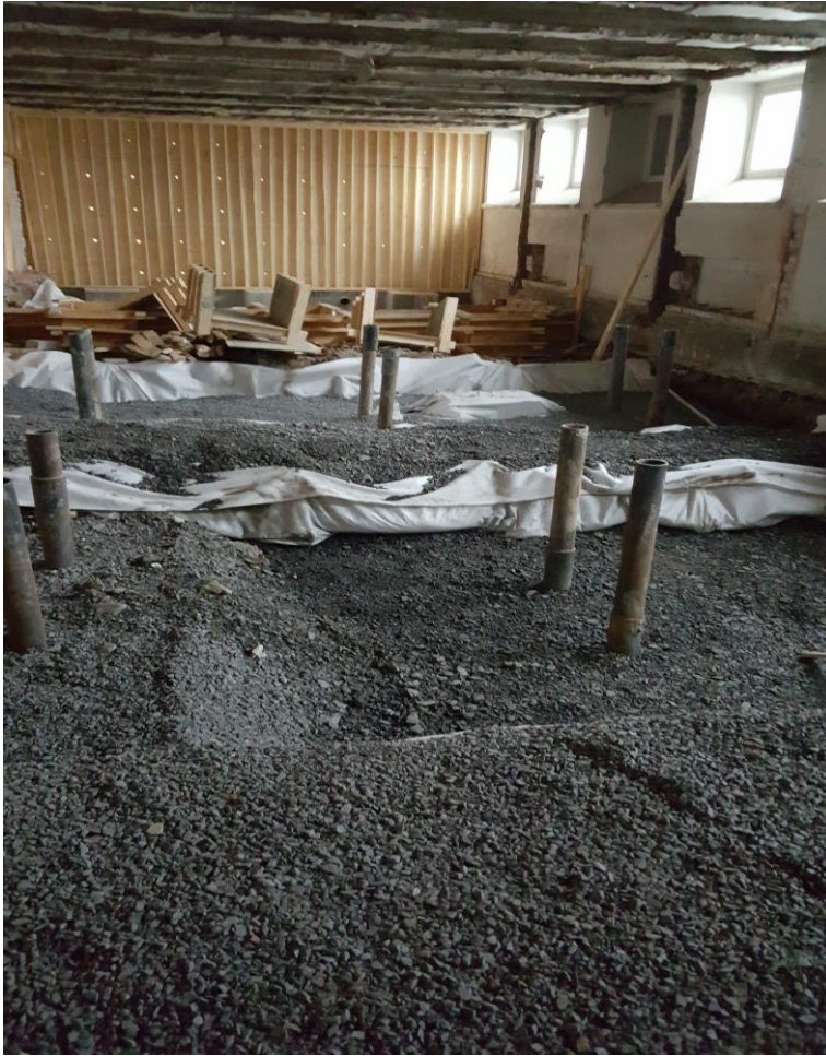
KUVA 10. Puhtaat maat kellarin anturalinjoilla
