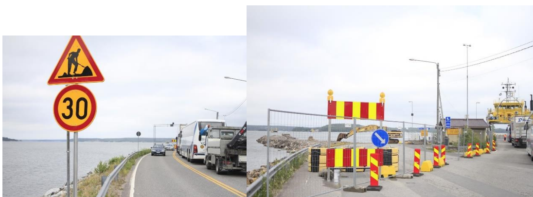
Bild 4 och 5: Vägarbetet vid Pargas-Nagu färjpass.
