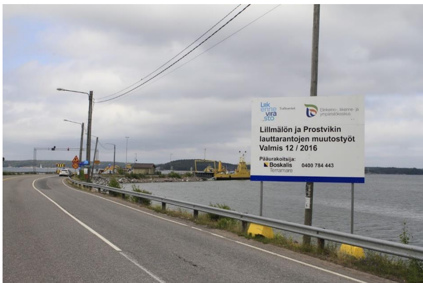
Bild 3: Information om bygnadsarbetet vid Pargas-Nagu färjpasset.
