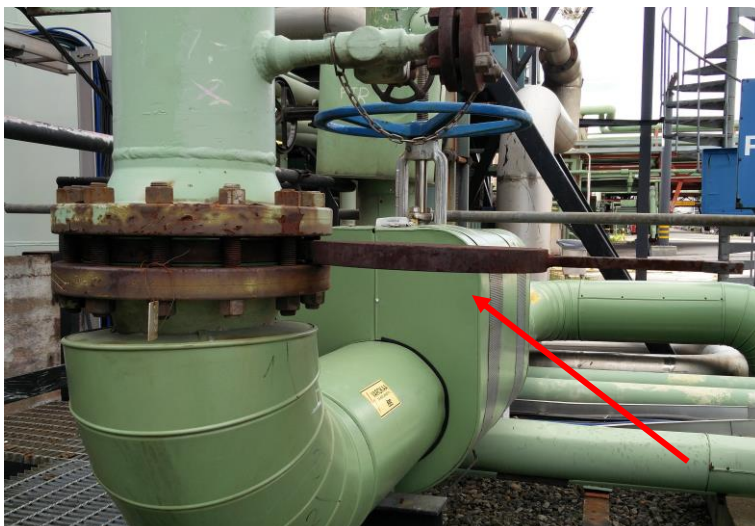
KUVA 6. Sokealaippa paikalleen asennettuna (Kuva: Arttu Tuominen 2016)
