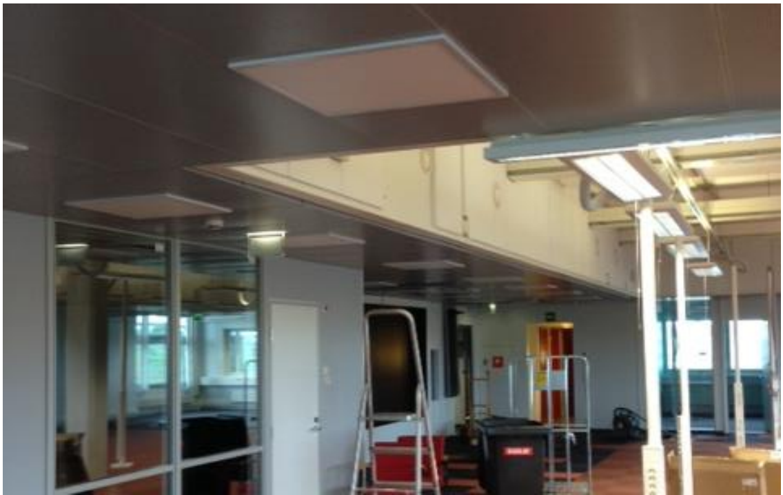
Kuva 14. LED-paneelit asennettuina
