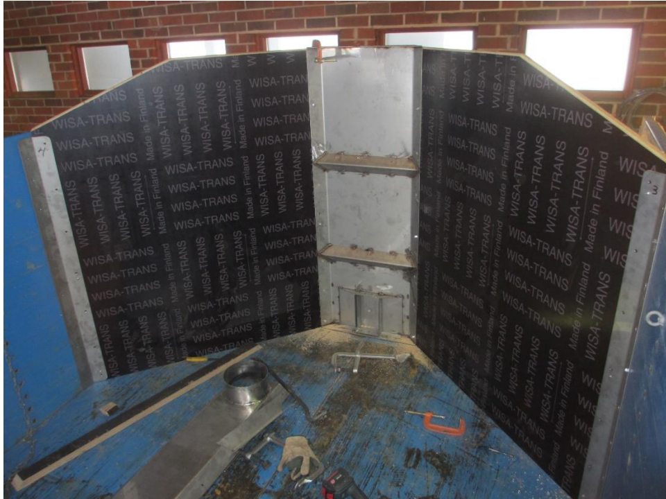
Kuva 13. Takimmainen välilaita alustavasti koottuna, perävaunun lavalla näkyy irtonaisena myös etumaisen jakolaidan keskipelti läpivienteineen
