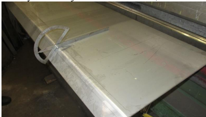
Kuva 10. Muotoonsa taivutettu takalaidan keskiosa
