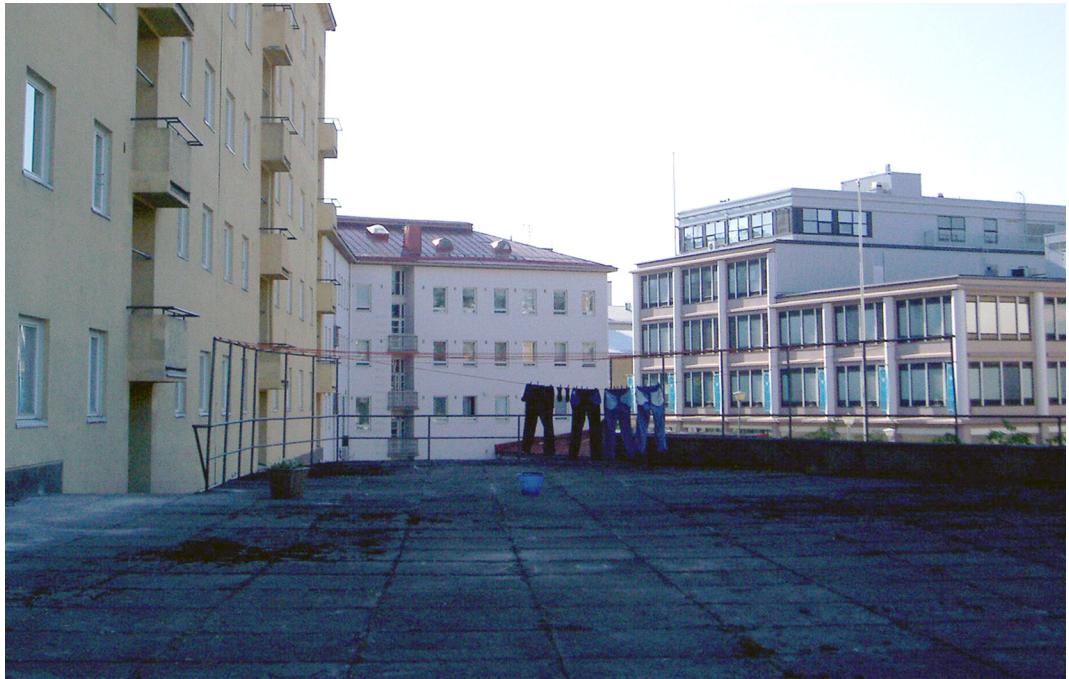
Kuva 21. Aleksanterinkatu 30. Näkymä suunnittelukohteen länsipäädystä.
