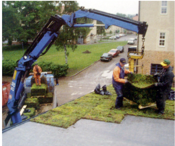
Kuva 8. Rakentajat levittävät esikasvatettua kasvimattoja katolle. (Veg Tech Suomi 2001.)
