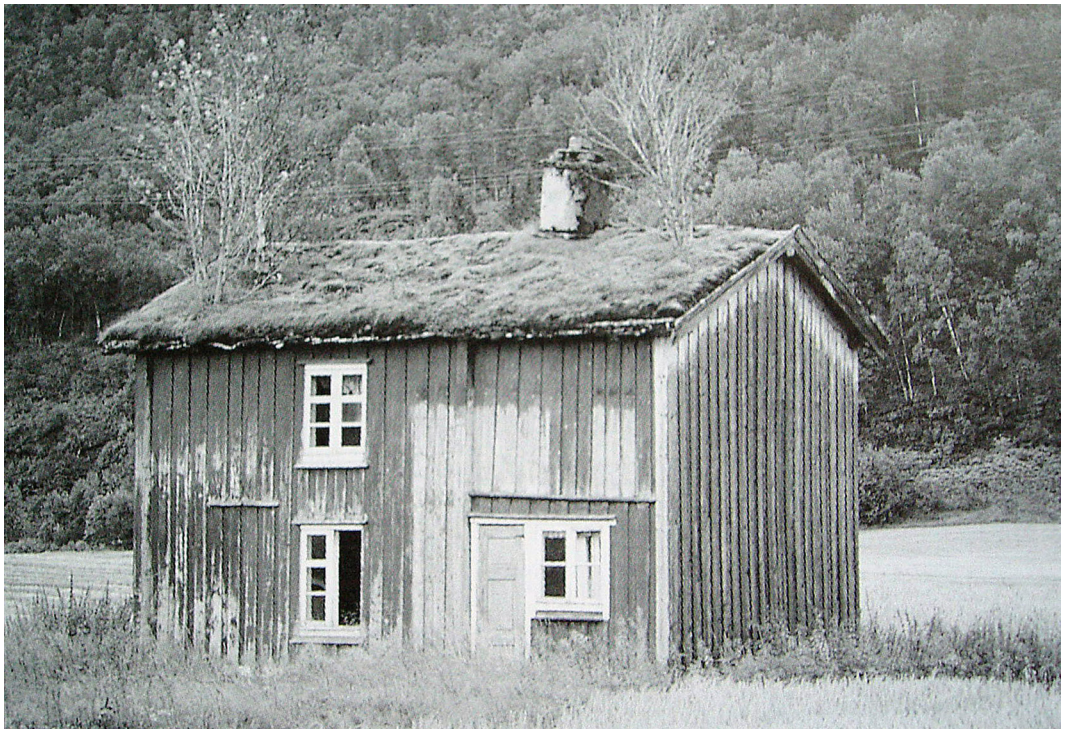
Kuva 3. Vanha norjalainen turvekatto. (Osmundson, 1999, 121.)
