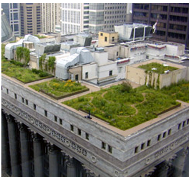
Kuva 12. Chicago City Hall.
