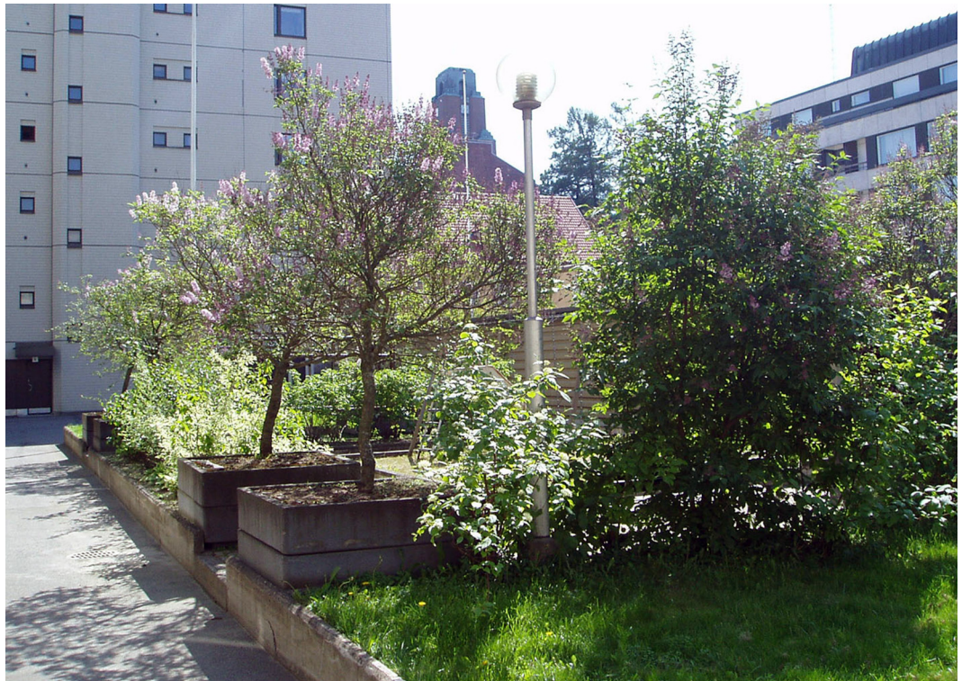
Kuva 15. Vuorikatu 20:n kasvikkatto alkaa kansipuutarhana ja muuttuu istutusalttaila vehreytetyksi kattopuutarhaksi.
