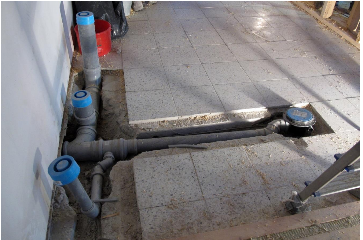
Kuva 19. Viemärivetoja suuremman huoneiston puolella.
