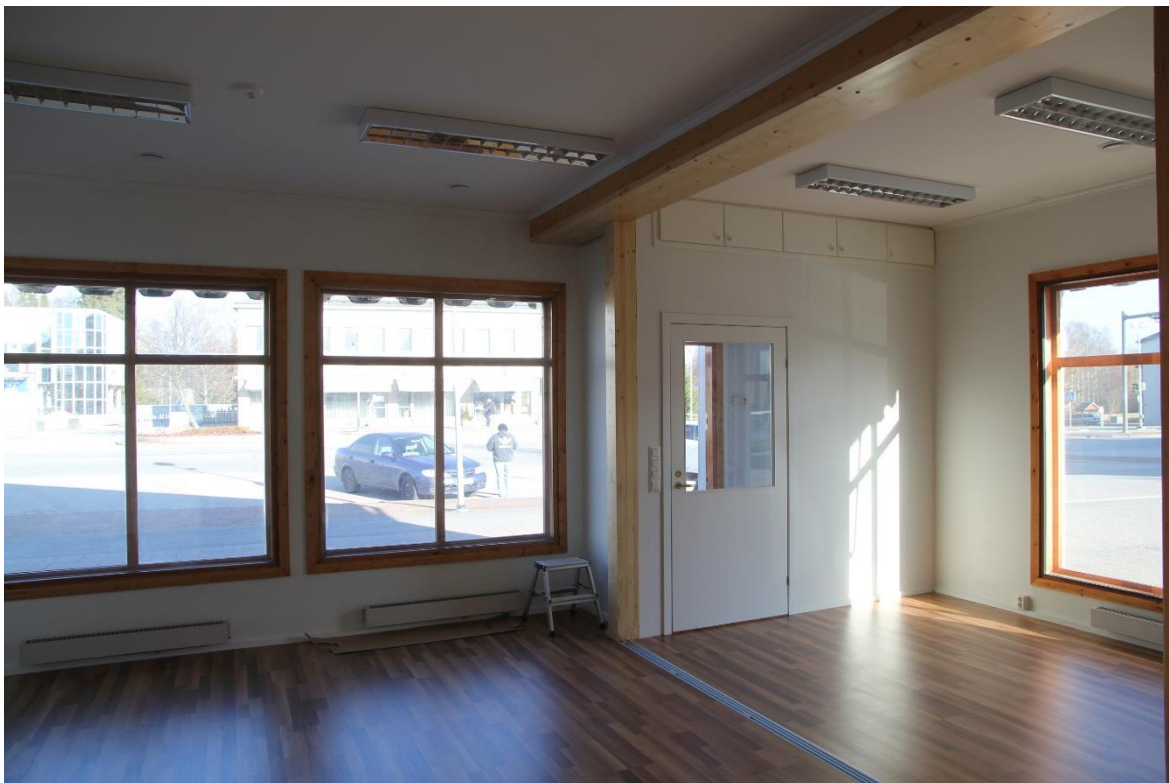
Kuva 22. Suurempi huoneisto saneerauksen loppuvaiheilla.
