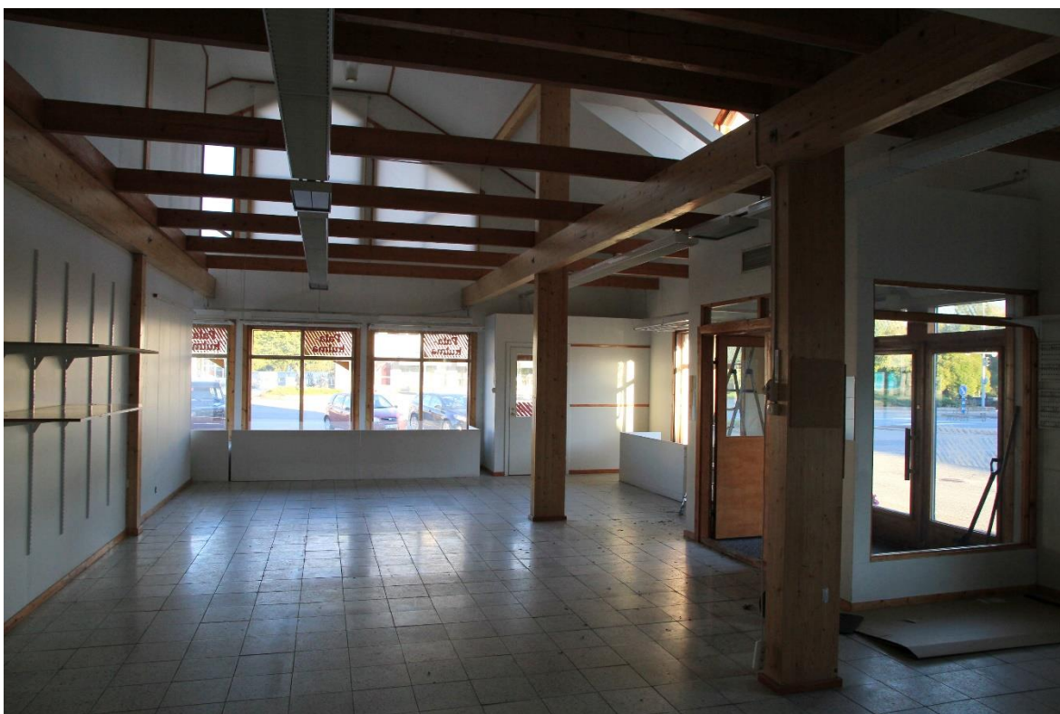
Kuva 13. Yleisnäkymää saneerattavasta tilasta ennen toimenpiteisiin ryhtymistä.
