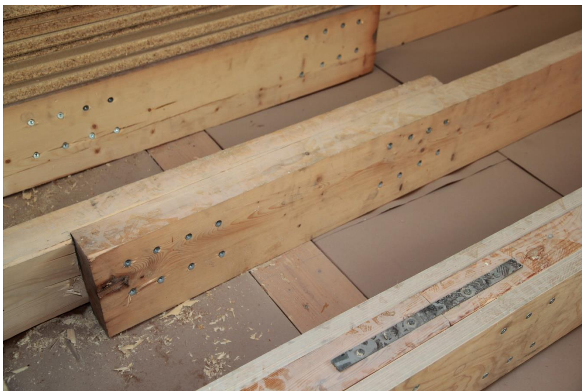
Kuva 15. Välipohjapalkin jatkosliitos asennettuna.
