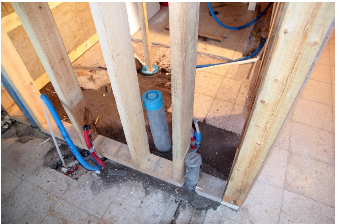
Kuva 20. Pienemmän huoneiston vesiputki- ja viemäriasennuksia.
