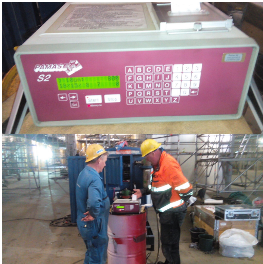
Kuva 13. Hiukkaslaskin ja alemmassa kuvassa putkiston puhdistusajo käynnissä.
