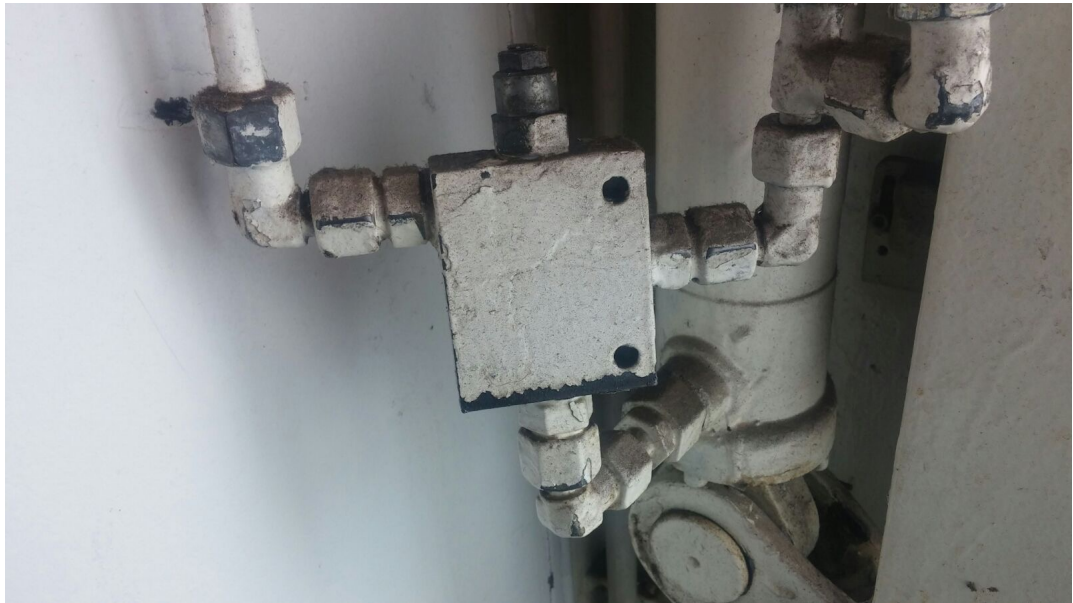
Kuva 11. Liittimet vuosivat hiukan joka puolelta.
