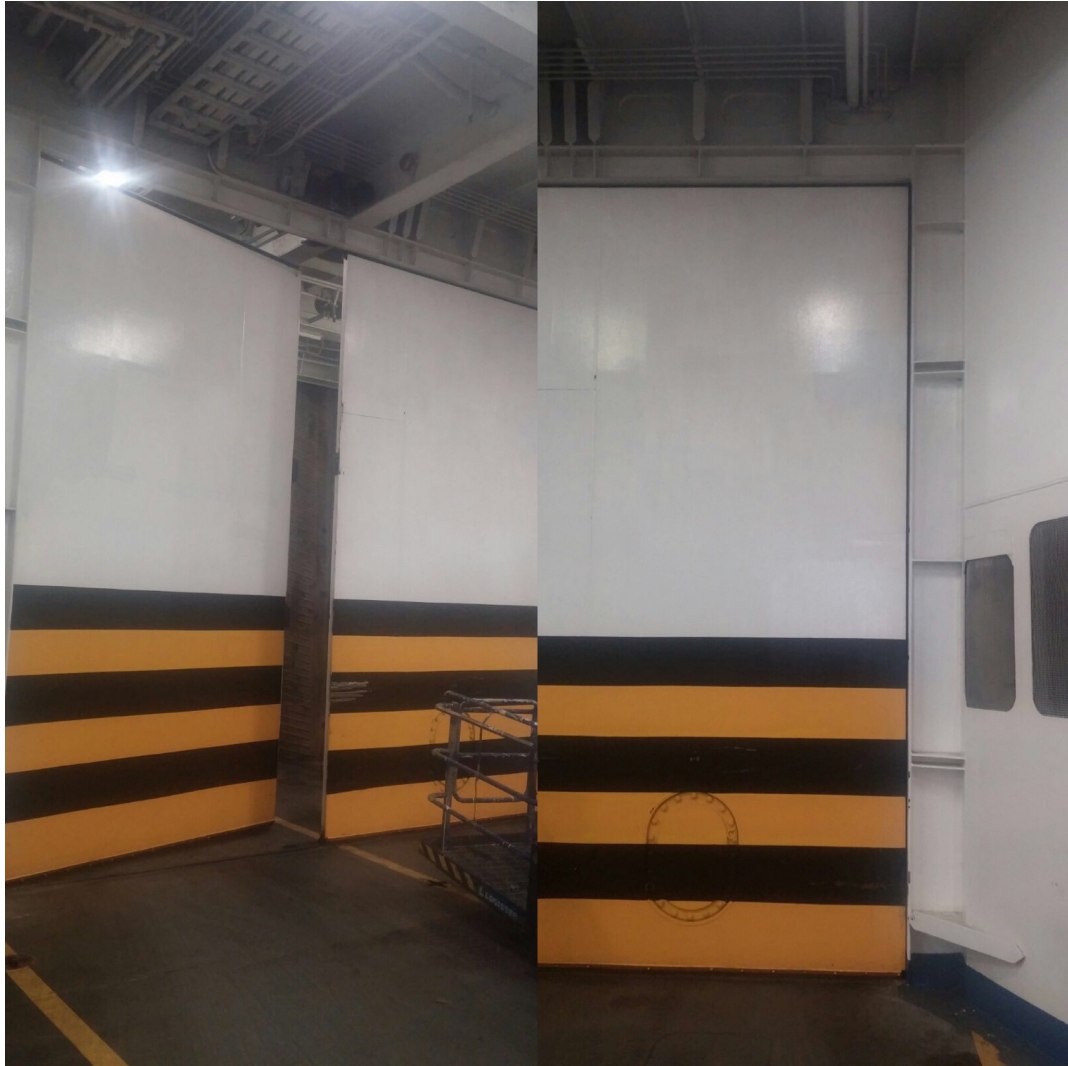
Kuva 1. Myrskyportin roikkumisen yläkulmasta näkee jo silmällä.
