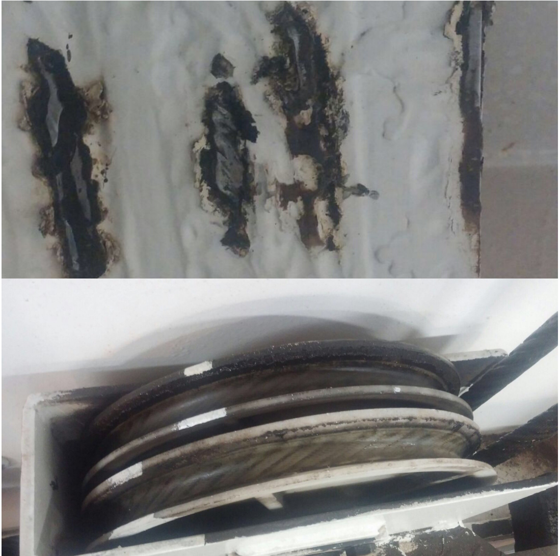
Kuva 7. Vaijeripyörä ottaa kiinni seinään.
