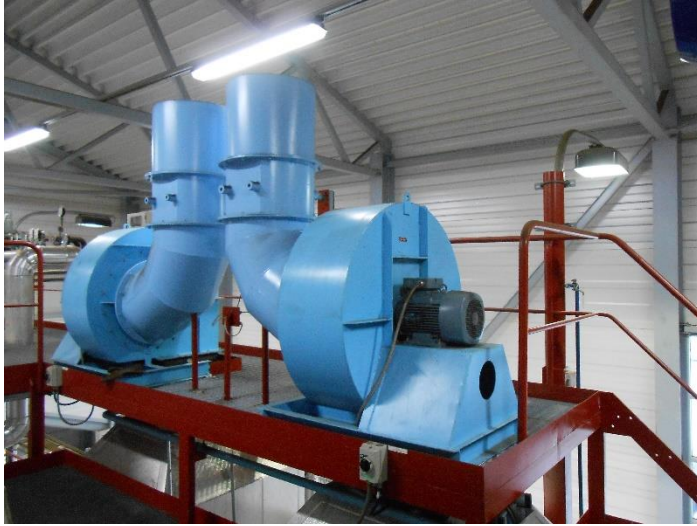
KUVA 8. KPA6 primääri- ja sekundääri-ilmapuhaltimet
