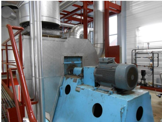
KUVA 10. KPA6-kattilan savukaasupuhallin
