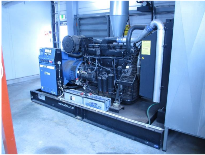
KUVA 16. Varavoimageneraattori
