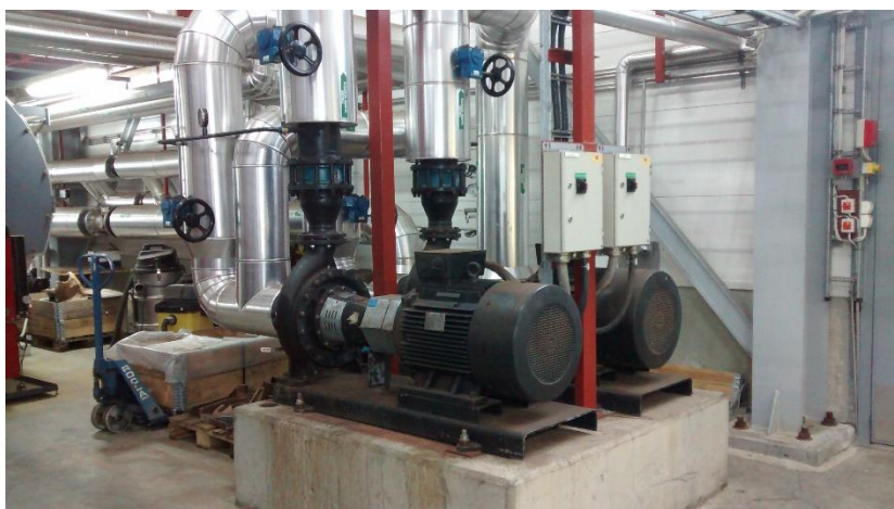
KUVA 12. Kaukolämpöpumput
