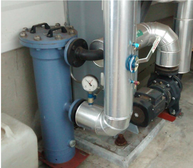
KUVA 14. Sivuvirtasuodatin
