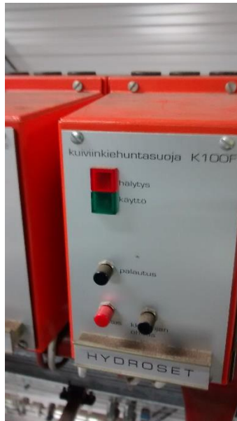
KUVA 3. Hydroset K100F kuivakiehuntasuoja
