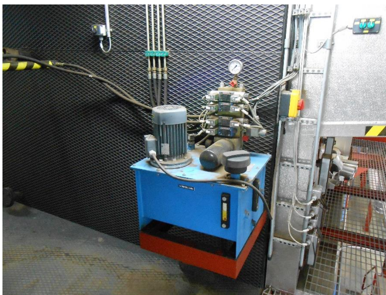
KUVA 7. Syötinhydrauliikkakoneikko
