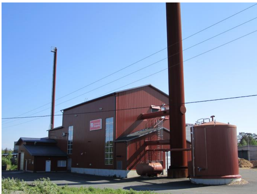
KUVA 2. Teollisuustien lämpölaitos (Keminmaan Energia Oy)
