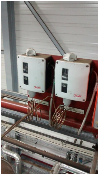
KUVA 5. Yliämpötermostaatteja
