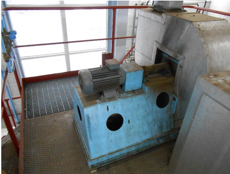
KUVA 9. Kiertokaasupuhallin
