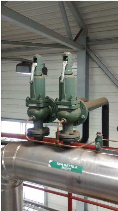
KUVA 4. Jousikuormitteisia varoventtiileitä
