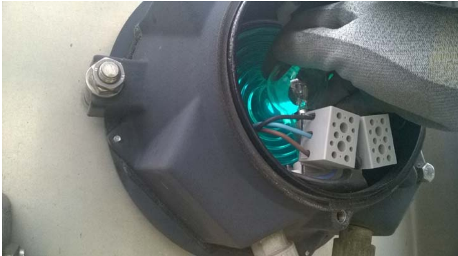
Kuva 51. Vaihdettiin lamppu opastimen valoyksikköön
