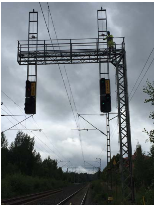
Kuva 50. Kammella veivattiin opastimet ylös.
