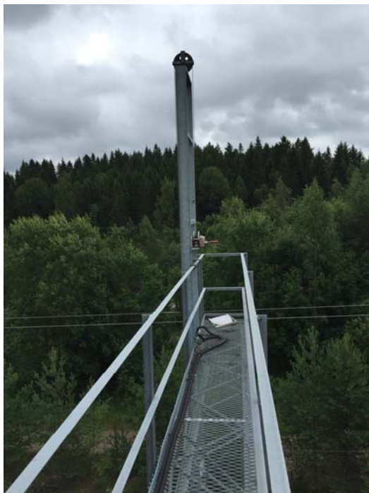
Kuva 48. Näkymä opastinsillalta opastimien vinssiin ja liukuihin.
