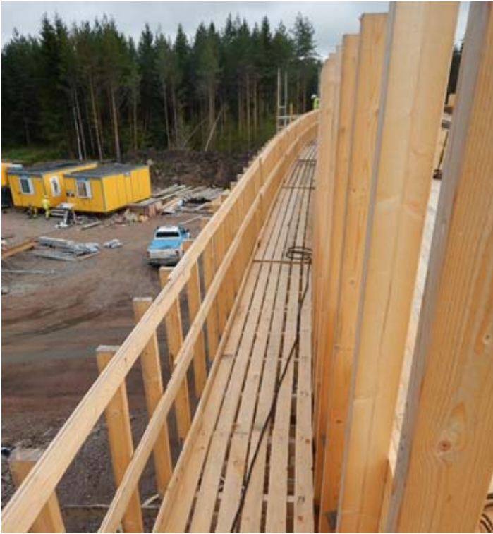
KUVA 5. Kansitason lankkukansi ja kulkutien suojaikaide
