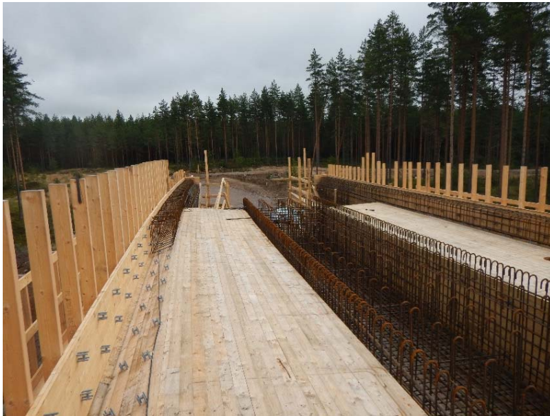
KUVA 7. Kannen muotti raudoitusvaiheessa
