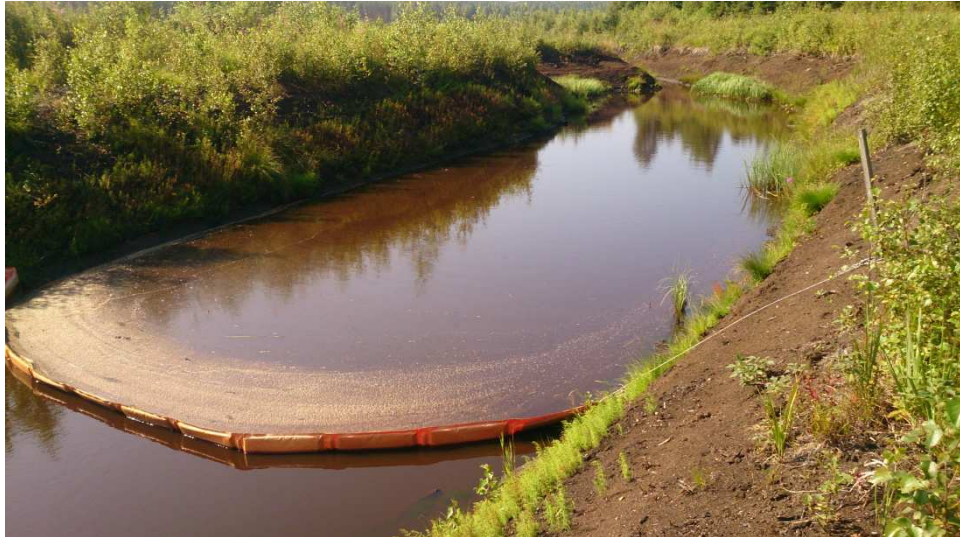
Kuva 4. Pintapuomilla varustettu laskeutusallas Rinnansuolla 26.7.2016.
