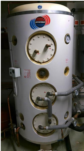
Kuvio 7. 400 L Akvaterm-lämminvesivaraaja Technobothnialla.
