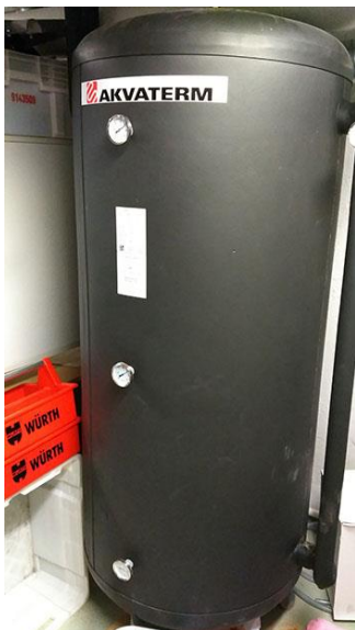
Kuvio 8. 750 L Akvaterm-vesivaraaja Technobothnialla.
