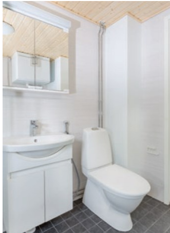
Kuva 4,5 Viemärin ja vesijohdon yhdistelmäelementti (PiPe-Modul Oy 2013, 9).
