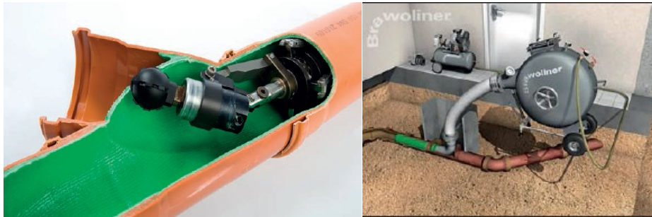
Kuva 10,11 Kiinteistoviemäreiden sukkasujutus (Suomen PutkistoPalvelu Oy).
