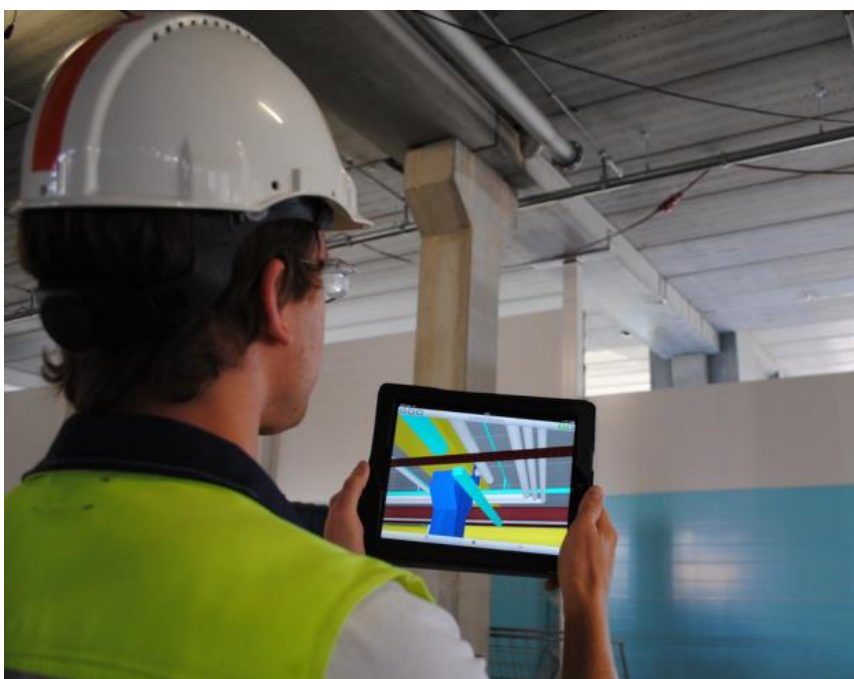
Kuva 8. Tietomallin hyödyntämistä itse paikalla työmaalla [31.]
