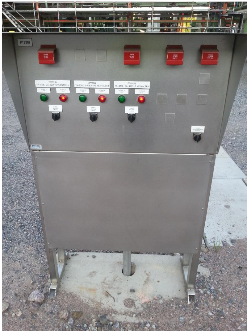
Kuva 6. BESSI-yksikön kenttäkytkintaulu.
