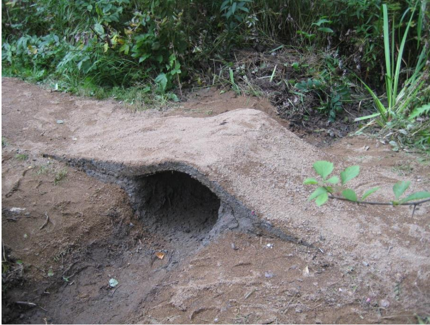
Kuva 4. Niksibetonista valettu pieni silta (Ekoinfo 2017).
