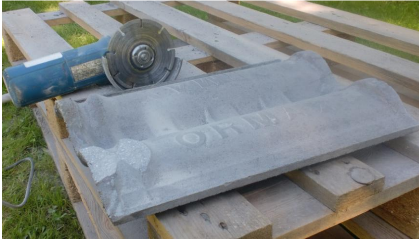
Kuva 5. Kattotiili muokattuna tiilikattokiinnikkeelle sopivaksi (Kuva: Timo Nykänen).
