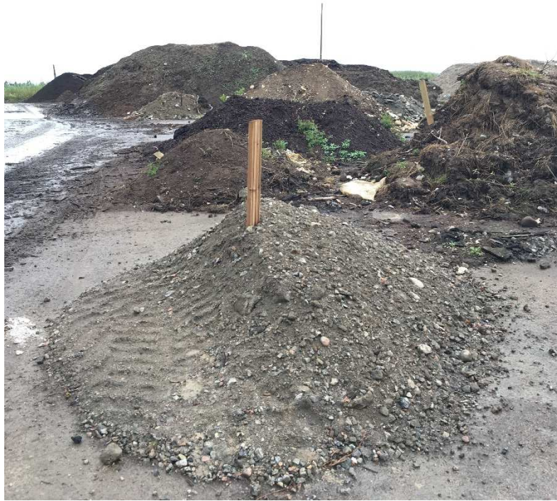
Kuva 16: Pilaantuneita maa-aineskasoja väliavarastoinnissa. Osassa kasoista on asiankuuluvasti merkitty. Merkkaamattomat kasat voivat mennä sekaisin ja voivat aiheuttaa turhaa työtä.
