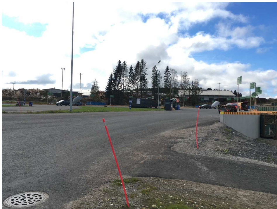
Kuva 9: Lajittelupihan laajennuksen jälkeen alueelle mahtuu hyvin purkamaan kuormaa.
