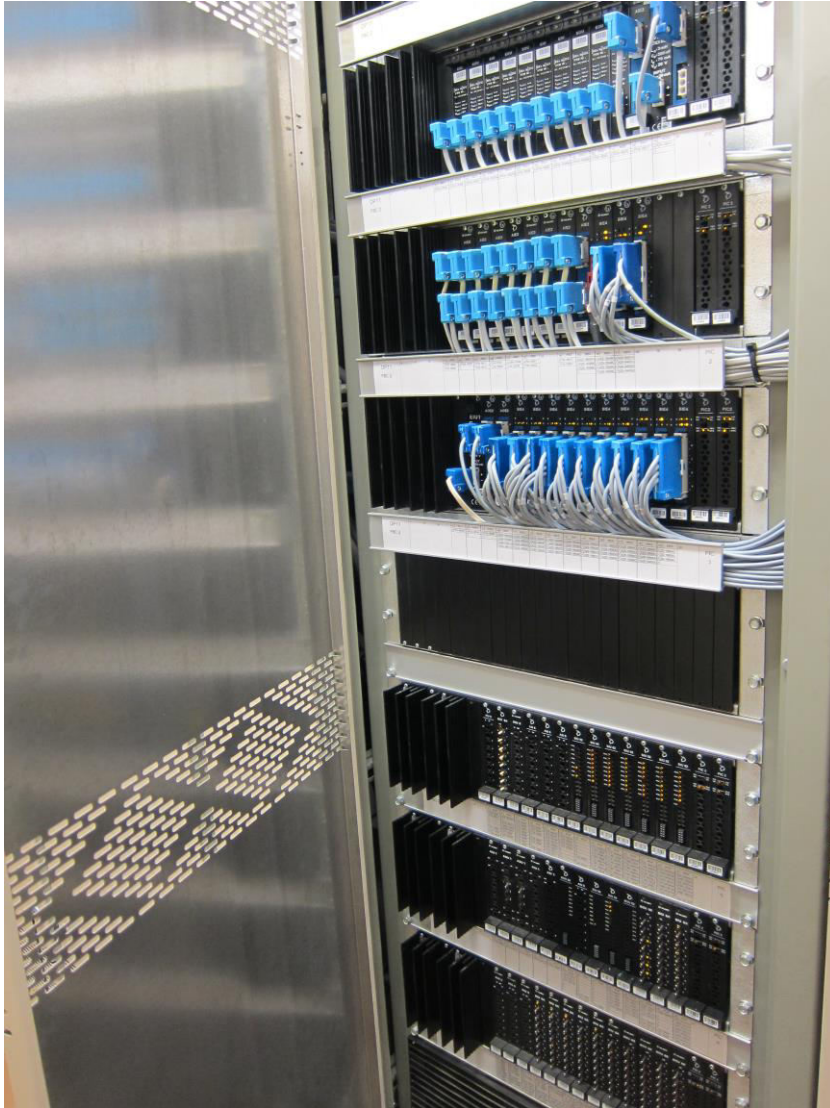
Kuva 9 AJ68-automaatiojärjestelmäkaappi
