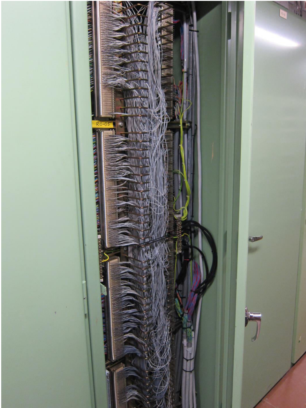
Kuva 8 RO-05-ristikytkentäkaappi
