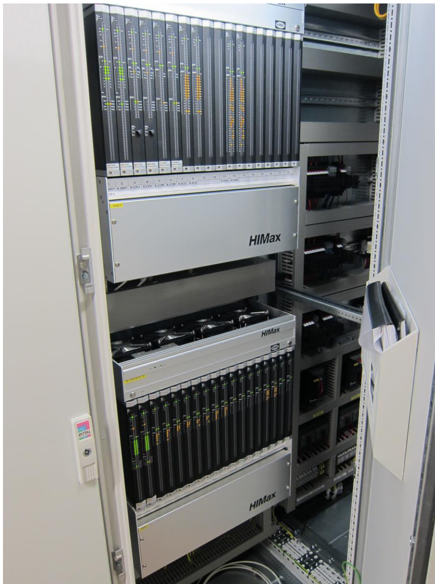
Kuva 11 SIS04-turva-automaatiojärjestelmä
