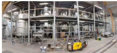
Vuoden 2016 syksyllä uusi öljynpuhdistusjärjestelmä alkoi olla loppusilausta vaille valmista.
