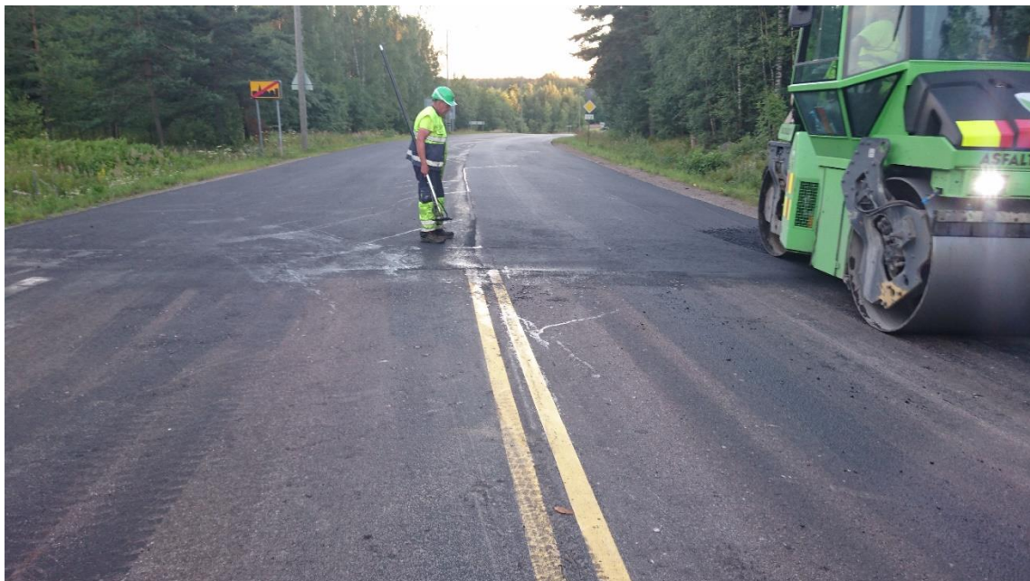
Kuva 19. Jyräyksellä tiivistetään levitetty asfalttimassa, (Ukkola 2016-7-29)
