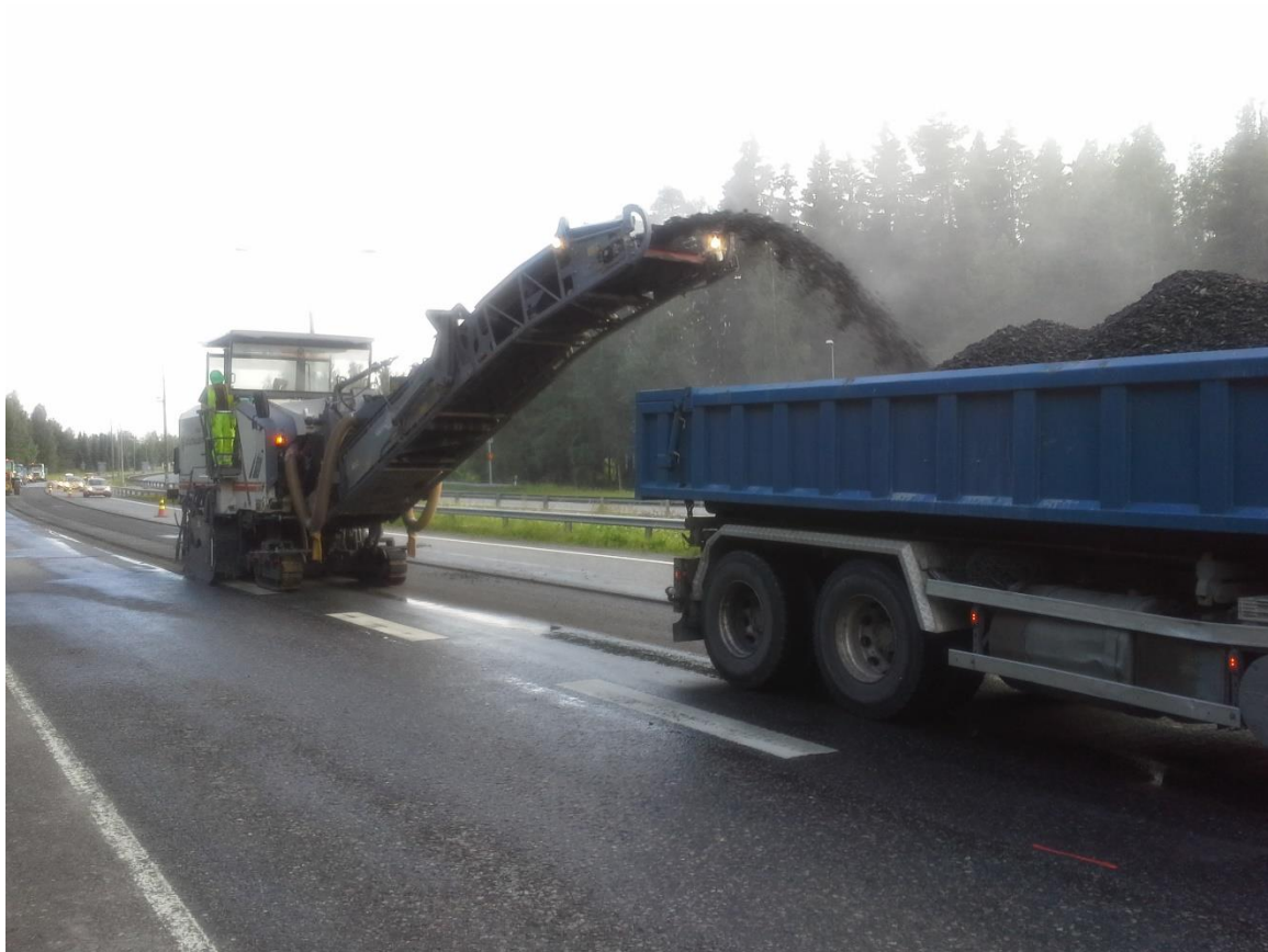
Kuva 15. Tasausjyrsintää (Asfalttikallio Oy)
