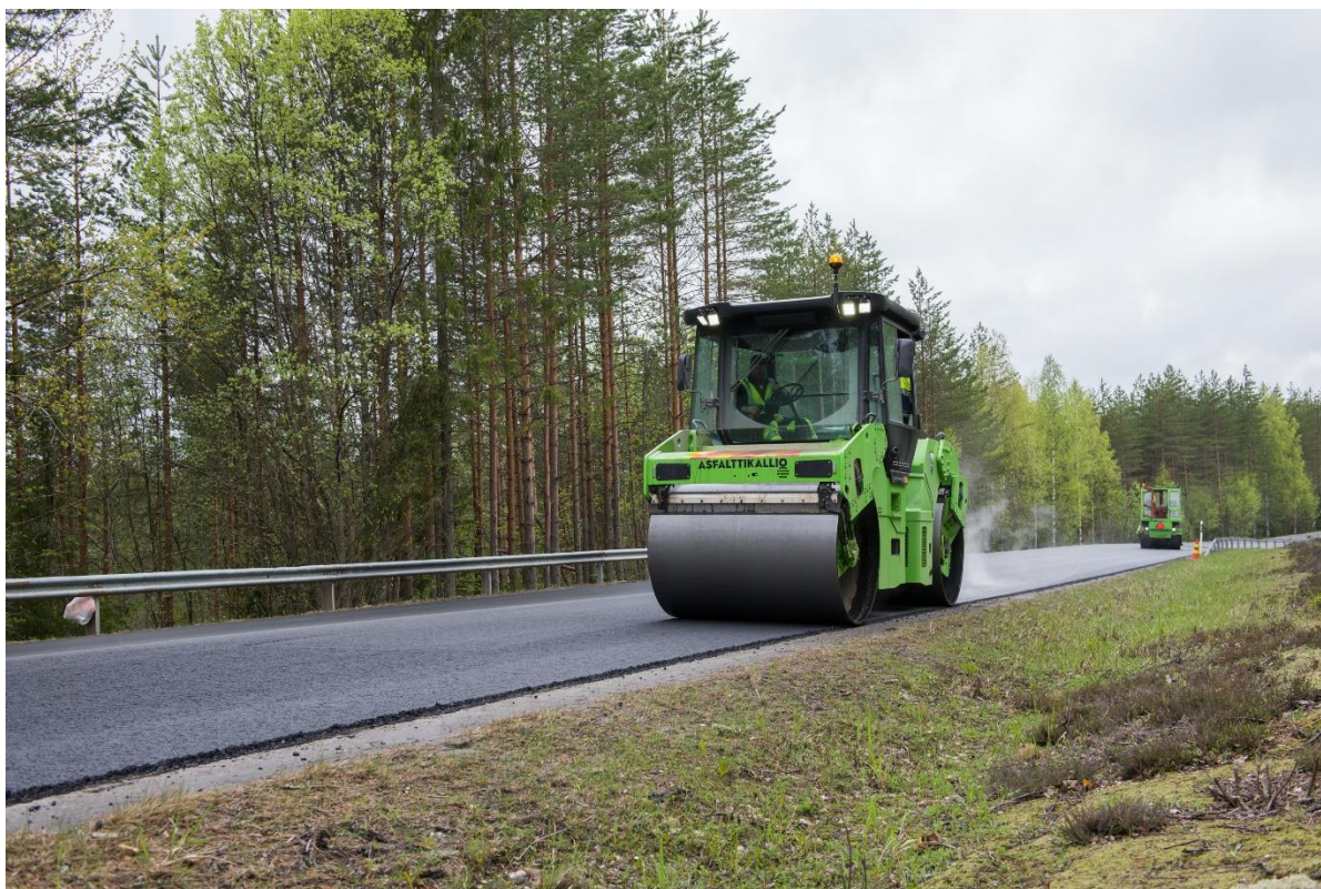
Kuva 12. Kaksivalssijyrä Remix työmaalla (Asfalttikallio Oy)
