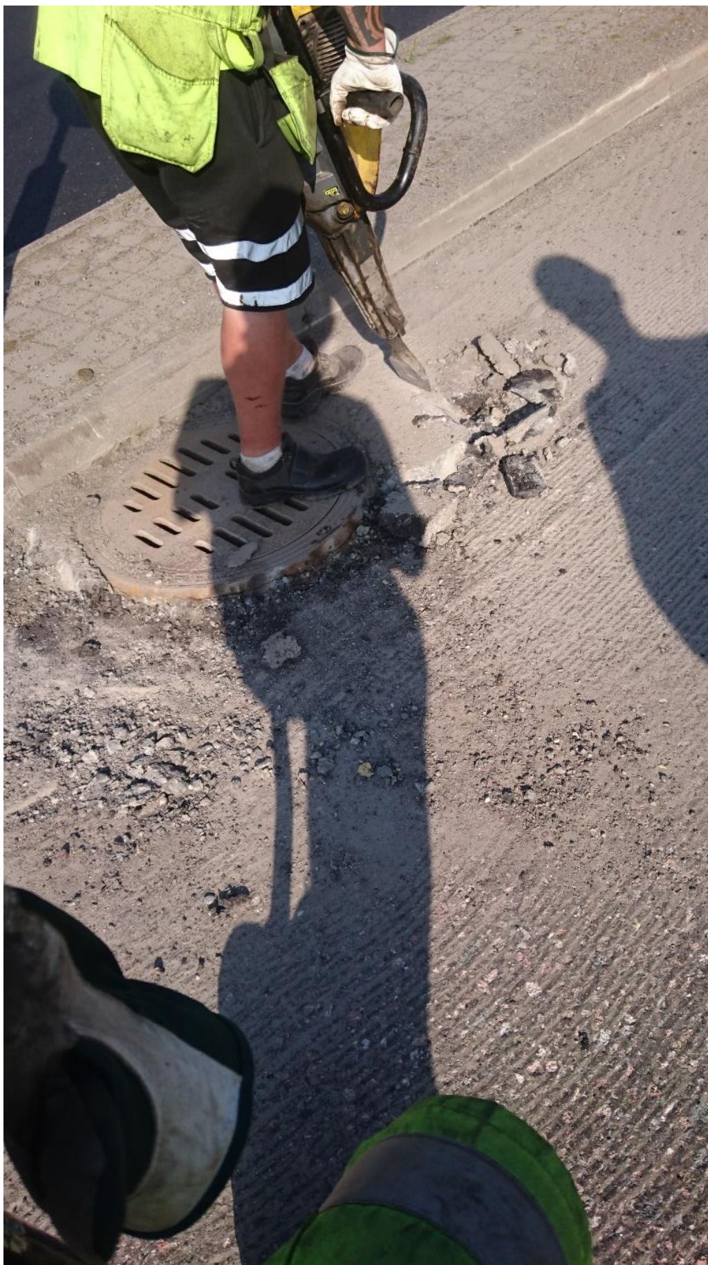
Kuva 18. Kaivon piikkaaminen irti (Ukkola 2016-7-19)
