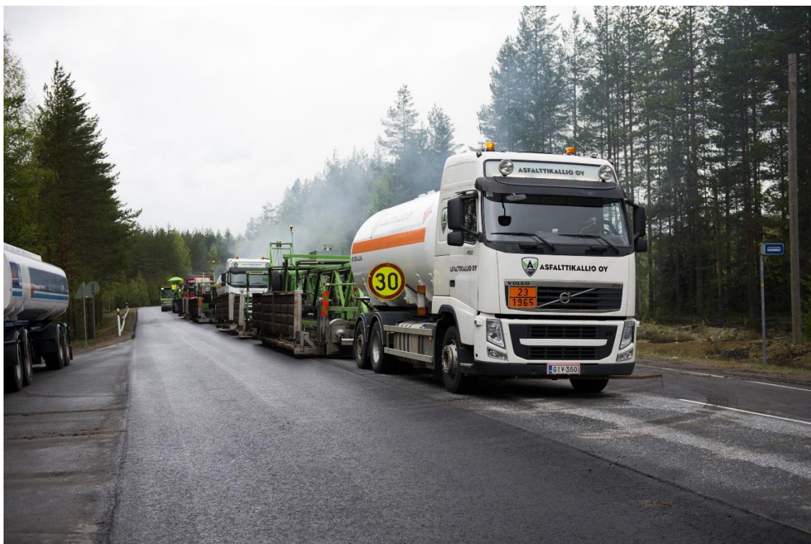
Kuva 3. Remixer-pintaus. (Asfalttikallio Oy)
