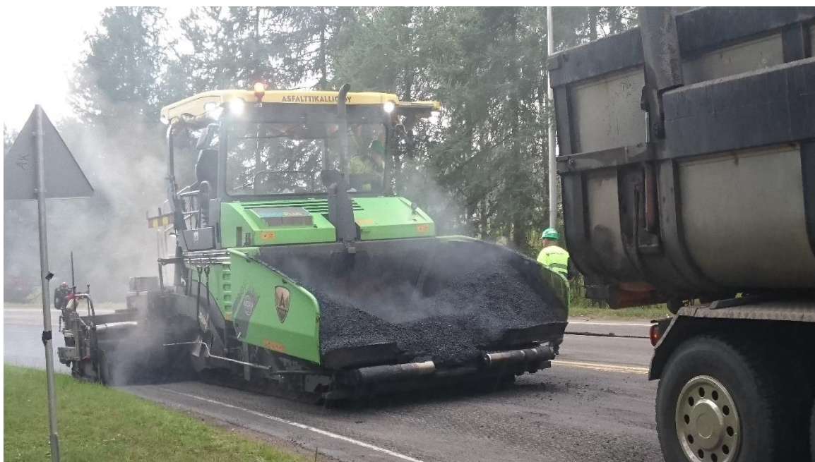
Kuva 9. Telavetoinen, sähköllä lämpiävä perä, Vögelen levitin (Ukkola 2016-7-25)
