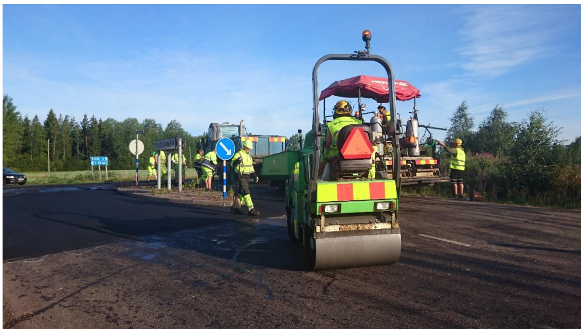
Kuva 17. Risteyksen päällystäminen (Ukkola 2016-7-19)
