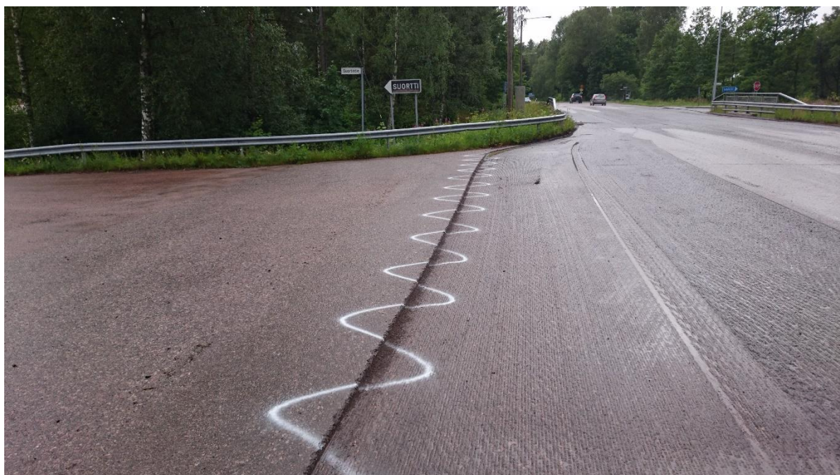
Kuva 16. Jyrsitty tartunta, merkkkaus asianmukaisella tavalla, jyrsinjäte poistettu, (Ukkola 2016-8-16)
