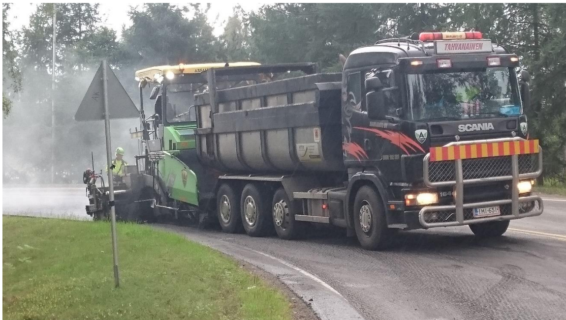
Kuva 13. Massa-auto puolipyöreällä asfalttilavalla, (Ukkola 2016-8-4)
