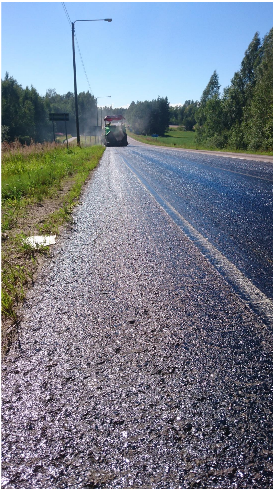
Kuva 7. Vanhan asfaltin päälle suoritettu liimaus (Ukkola 2016-7-5)
