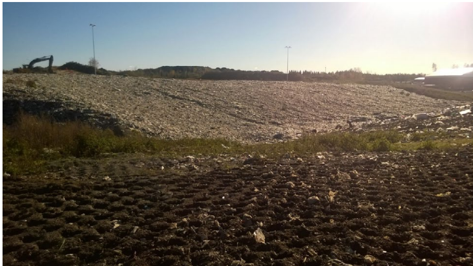
KUVA 6. Uusiomateriaaleja voidaan käyttää kaatopaikkarakenteissa (kuva Niina Laurila)
