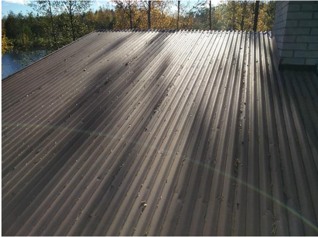
Maalattu peltikate ei ruostetta
