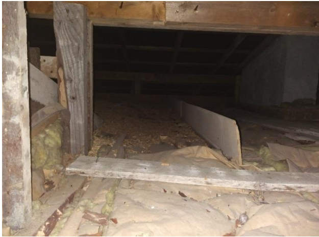
Eristeenä kutterinlastua ja lasivillaa
