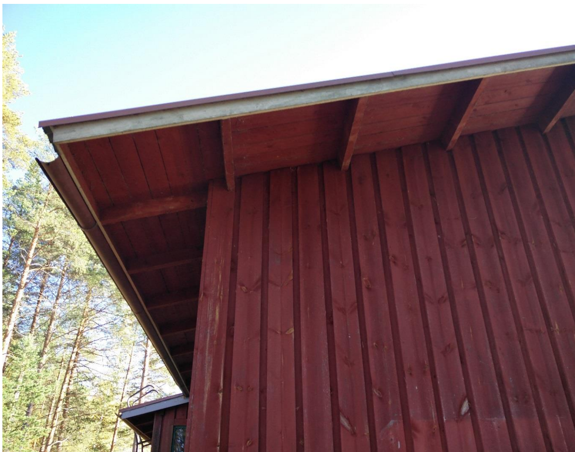
Kuva 2. Yläpuolelta tehdyt räystäät. (Röntynen Tero 2016)
