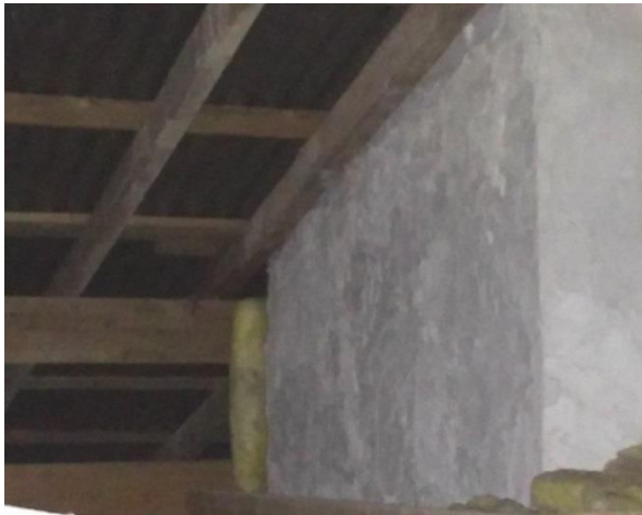
Savupiipun eriste vain eristetilan yläpintaan
