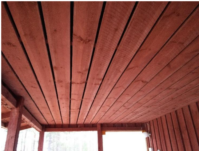
Yläpohjan tuuletus terassin harvalauta laipion kautta
