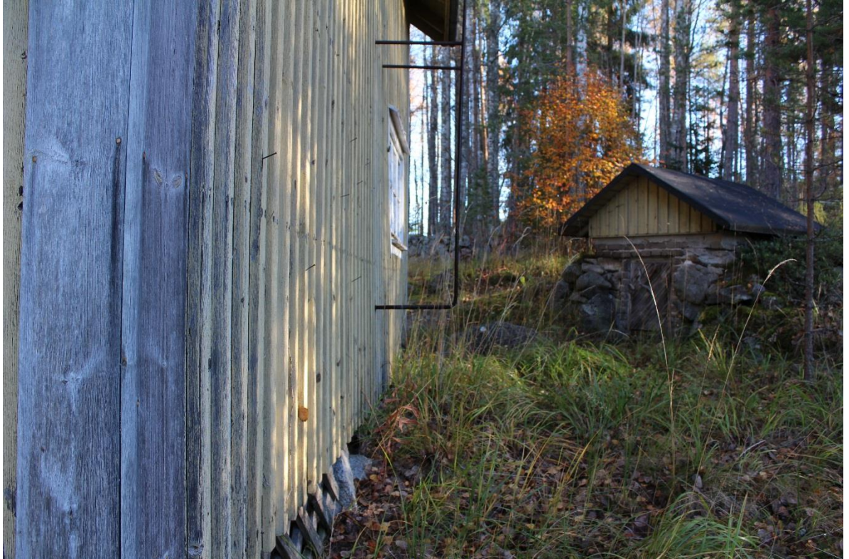
KUVA 5. Rakennuksen eteläpuoli (Antti Koponen 2016)
