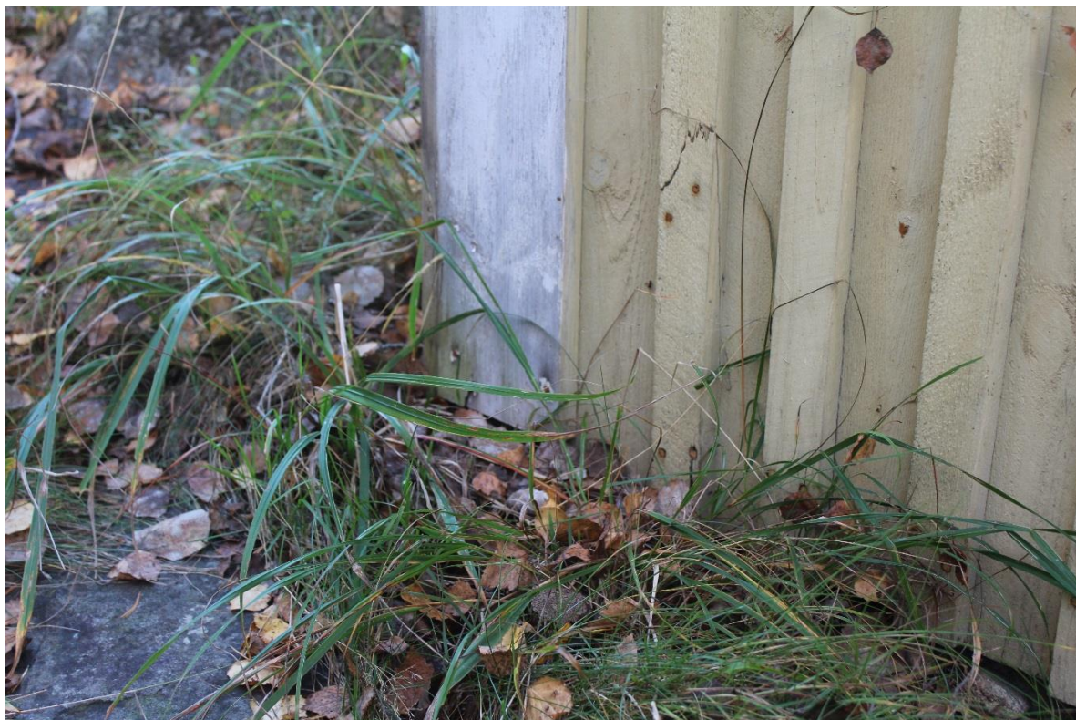
KUVA 8. Rakennuksen nurkka on maanpinnan korkeudella (Antti Koponen 2016).
