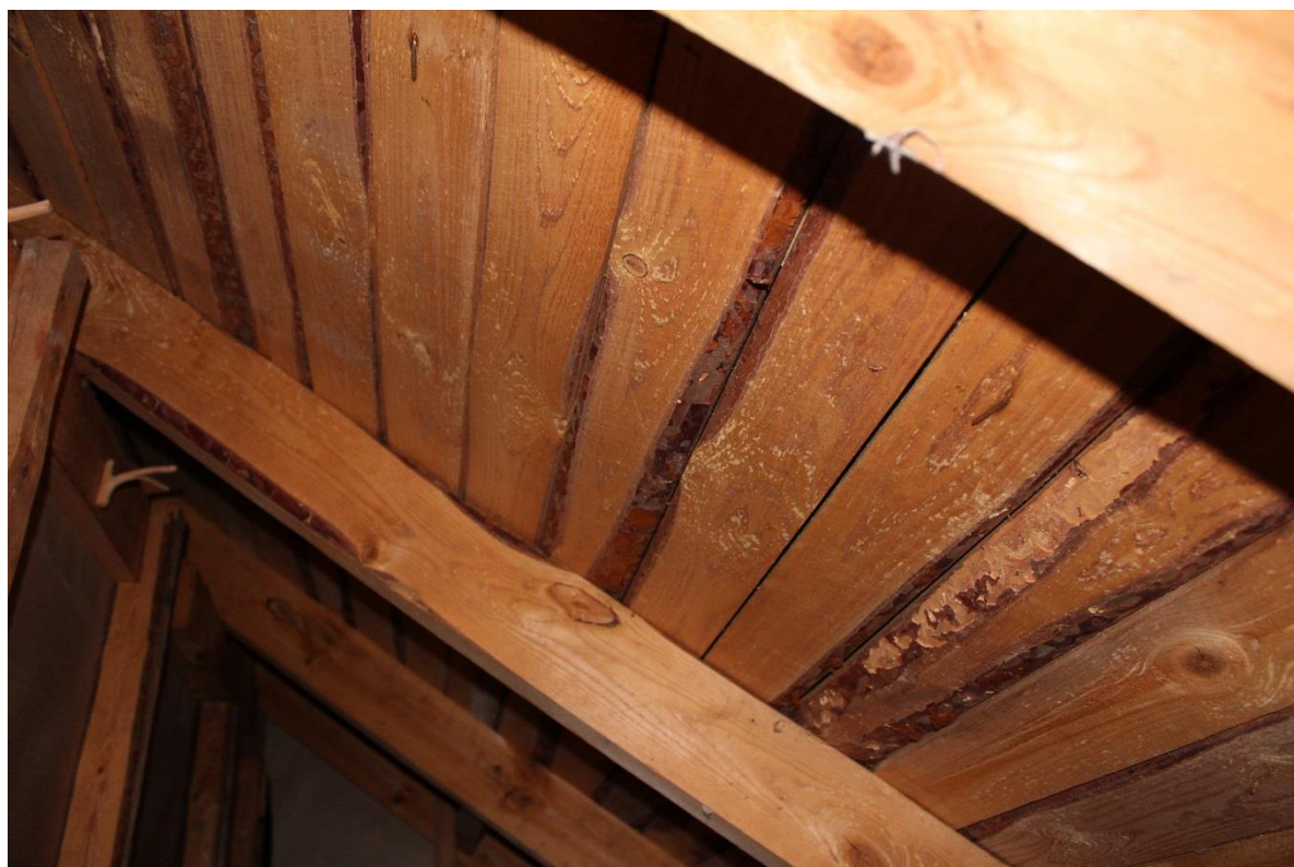
KUVA 17. Umpilaudoitus on kunnossa (Antti Koponen 2016).
