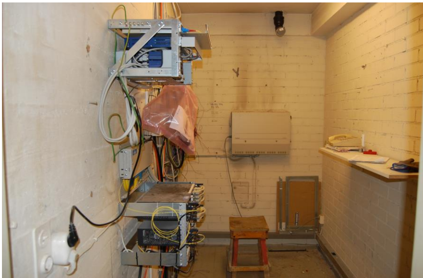
Kuva 6. Kellarin puhelinjakamo.
